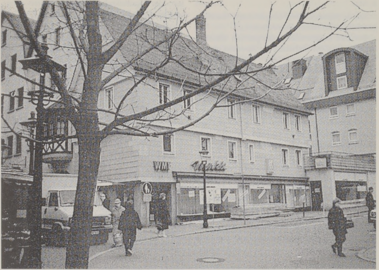
Das Haus Schillerstraße 11 im alten Zustand.
