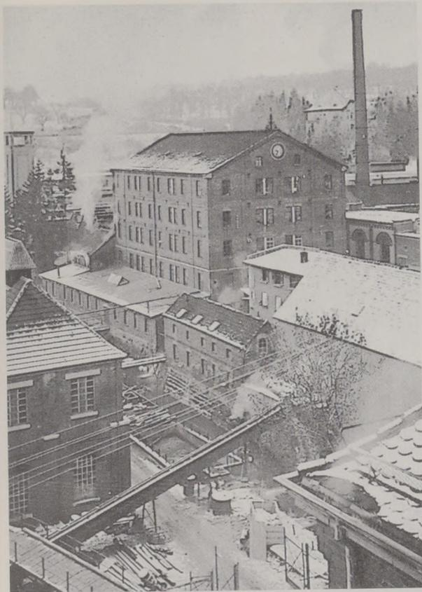
*Bild 32: Auf diesem vom Dach von Werk 2 aufgenommenen Foto von 1932 sind bis auf das Wohnhaus alle bis 1886 entstandenen Gebäude gut erkennbar. Der 1876 errichtete erste gemauerte Schornstein ist bereits abgebrochen und das Kesselhaus sicher anderweitig genutzt. Vorn die von der Straße „Spinnerei“ kommende eiserne Wasserrinne. Links die aufgestockte Färberei/Bleicherei.*
