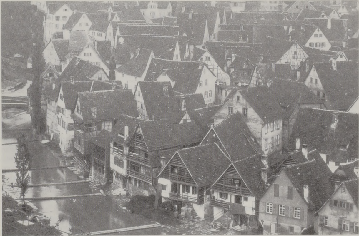
Auf diesem 1892 fotografierten Ausschnitt vom Biegel ist Jakob Breuningers ehemaliges Anwesen zu sehen. Die vierte Anweisung (schwimmender begehbare Steg der Gerber) murraufwärts ist bei seinem Trockenhaus 10a (548) – 1851 vergrößert und dreigeschossig – festgemacht. Rechts daneben, das hohe Haus mit Fachwerkgiebel, ist das Wohnhaus mit Gerberei 10 (247). Dahinter (rechts) das Gasthaus „zum Adler“.
