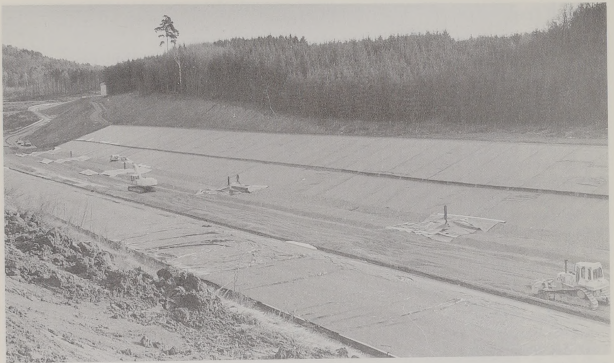
Mit hohem technischen Aufwand hergerichtet: Müllleinbaufläche auf der erweiterten Deponie Steinbach.
