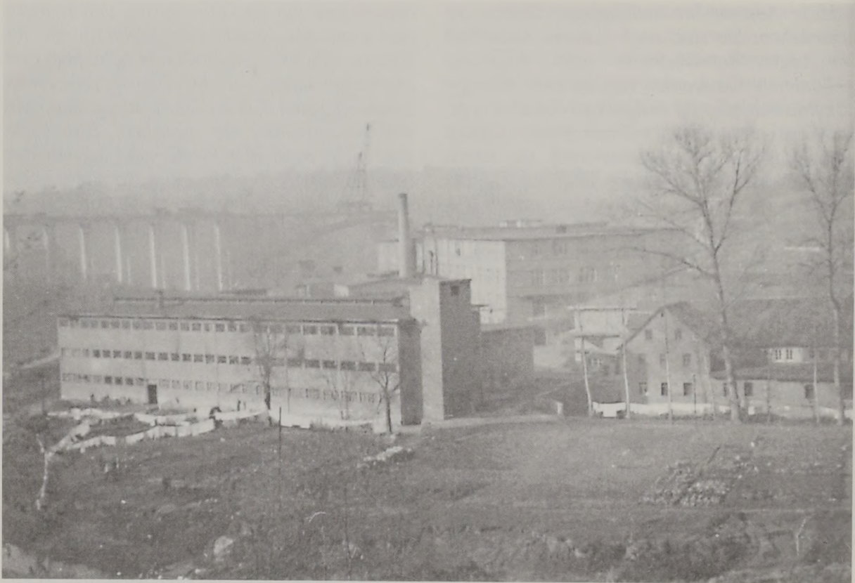
Lederwerke Backnang, 1948: Vordergrund links: In den beiden obersten Stockwerken Lager „Leba“. Hintergrund: Wiederaufbau des 1945 gesprengten MurrtaIviadukts.
