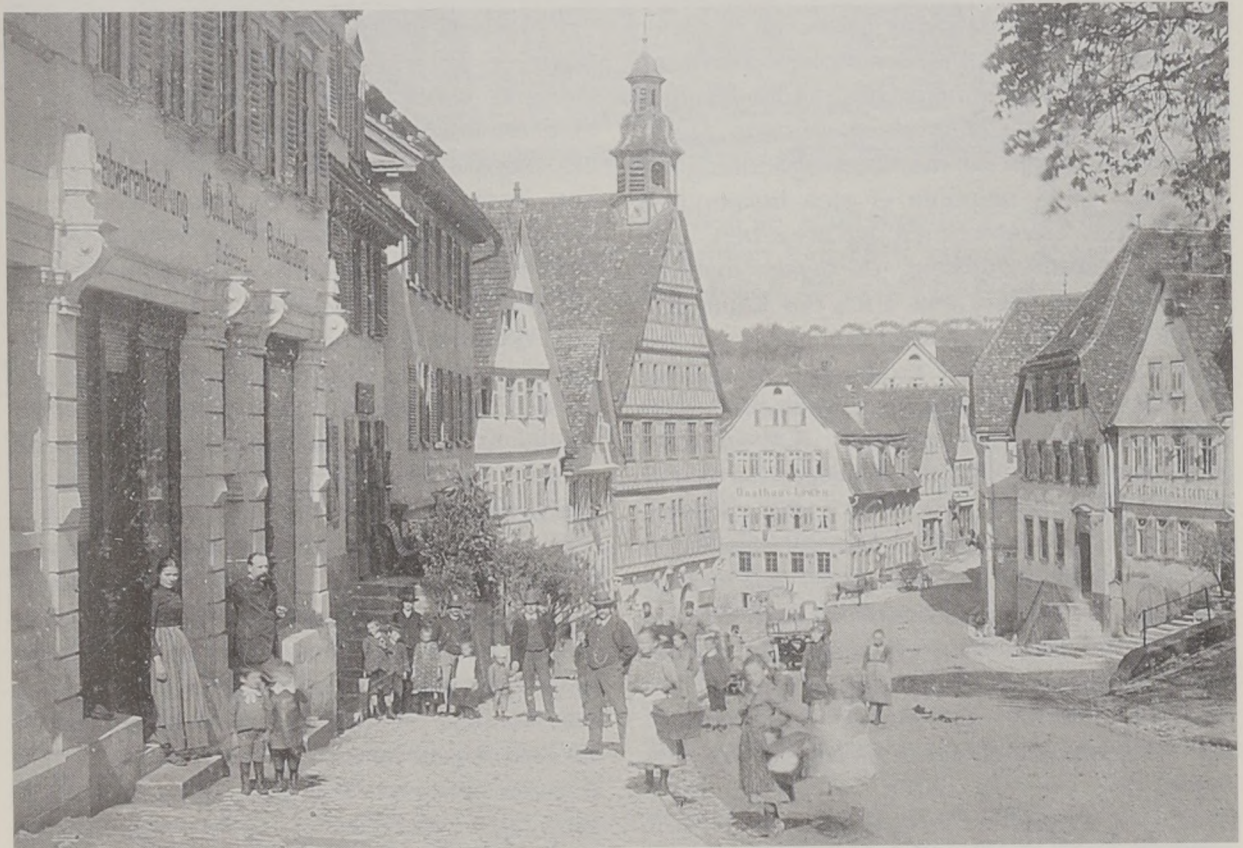
Marktplatz und Marktstraße um 1898. Links, in der Mitte der Gebäudegruppe, das Haus des Kaufmanns Schäfer, der 1845 die Untere Spinnerei ersteigert hatte. Links davor das Haus des Buchhändlers Albrecht, das 1959 für den Neubau des Metzgers Kühnle abgebrochen wurde.
