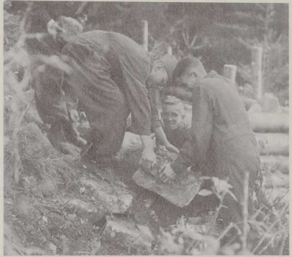
Beim Bau von Erdbunkern für Munition.
