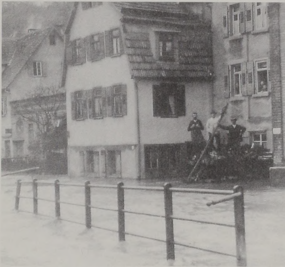
Abb. 69: Das Hochwasser vom 6. März 1914. Die Bad(Tal)straße steht 50 cm unter Wasser.
