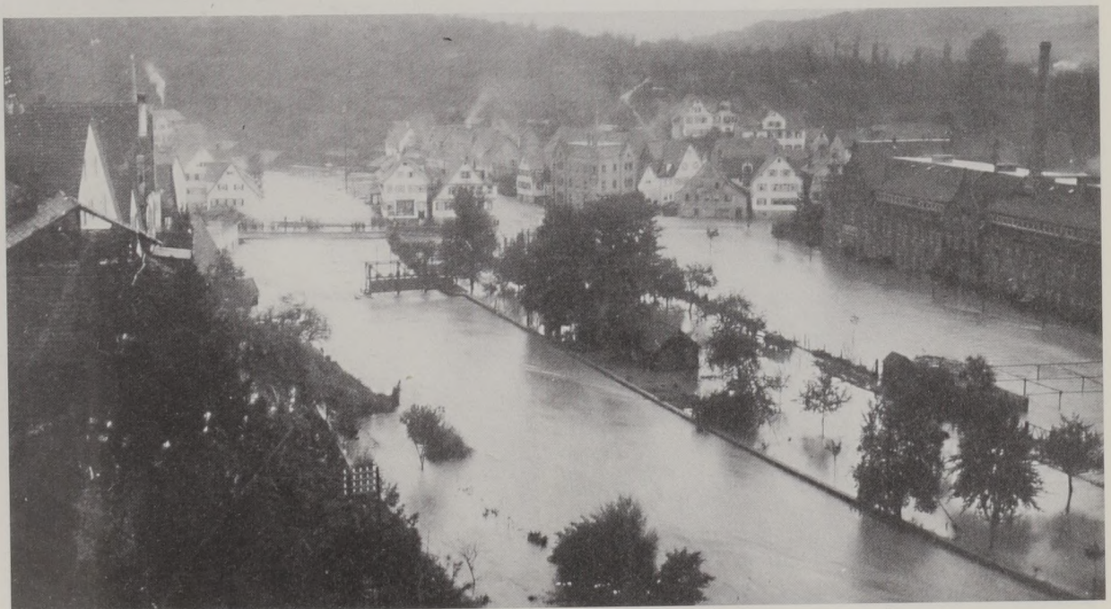
Abb. 68: Das Hochwasser vom 9. September 1912 mit einem Anstieg von mehr als 2,00 m zeigt die Grenzen von Regulierungsarbeiten im Bereich der Sulzbacher Brücke auf.
