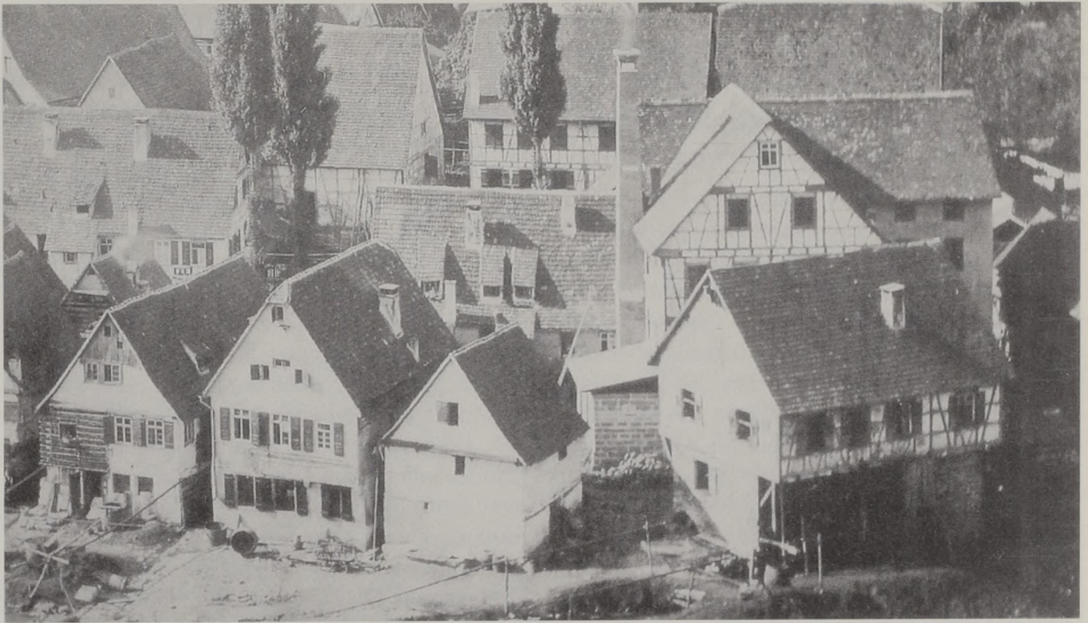
Abb. 21: Die Lederfabrik Carl Kaess im Biegel im Jahr 1874. In der zweiten Reihe stehen von links: das Wohnhaus 228, der Kesselhaus-Anbau mit dem 17 m hohen Schornstein und der dreigeschossige Gerberei-Anbau 229 an der Rückseite des Gebäudes 228 A. Dahinter die 1865 erweiterte Scheuer 226 mit der Farbenwerkstatt und einer 1871/72 angebauten Farbenwerkstatt an der Rückseite. Rechts davon die teilweise in Besitz befindliche Scheuer 227.
