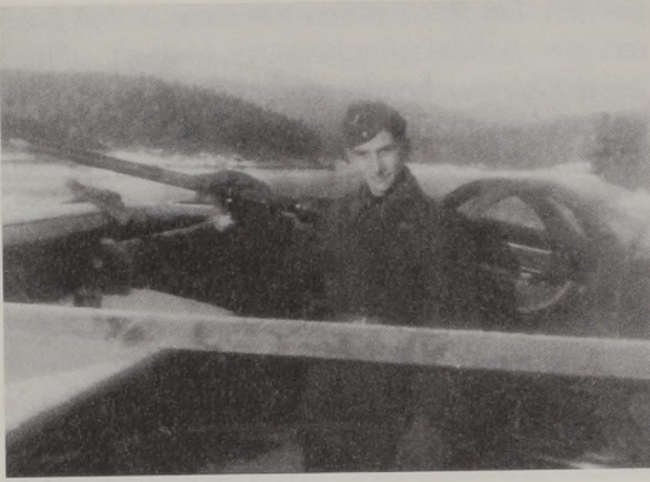
Flakhelfer Eberhard Langbein aus Backnang am 4. Geschütz auf der Mauerkrone.
