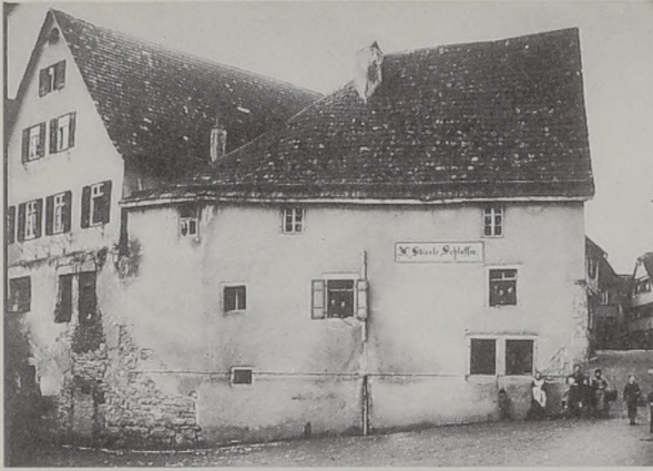
Abb. 63: Das Haus von Schlosser Stierle stand dem Verkehr der neuen Brücke im Weg. Murrseite mit Teil der Stadtmauer, links (März 1904).
