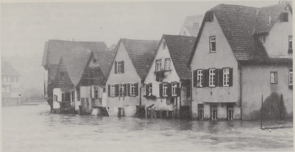
Abb. 62: Die Biegel-Häuser beim Hochwasser von 1914 mit einem Anstieg von fast 2,00 m.
