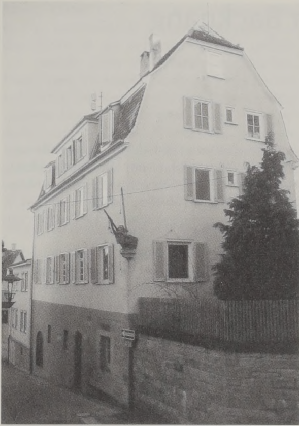
Das sog. Belsersche Schulhaus (Stiftshof 1).
