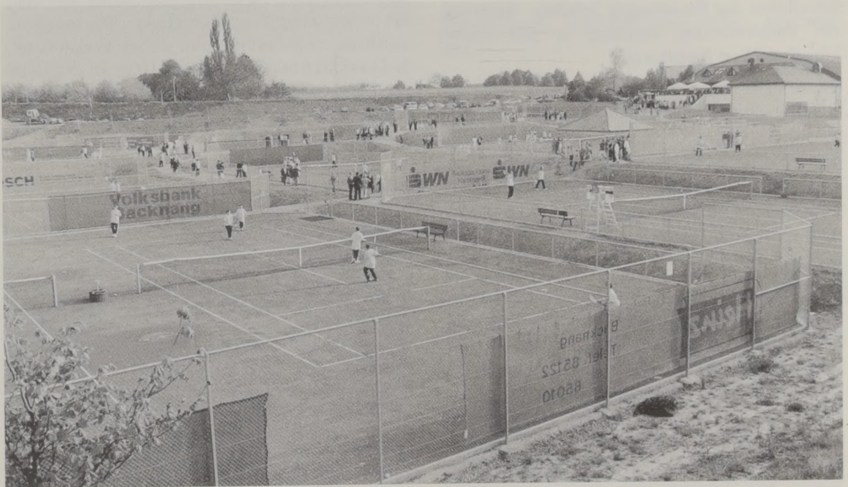
Einweihung der neuen 14-Plätze-Anlage der TSG Tennis bei der vereinseigenen Dreifeldhalle an der Weissacher Straße/Ungeheuerhof. Bisher befanden sich die Freiluftplätze an der Hohenheimer Straße.
