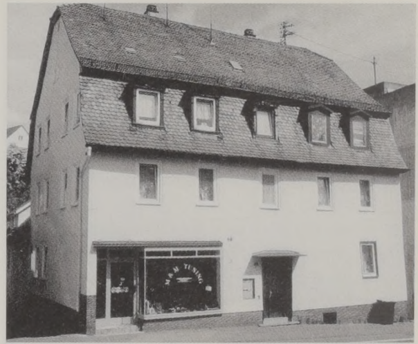
Abb. 18: Das frühere Gerbereigebäude Wilh. Ehmann, Sulzbacher Straße 44, im Jahr 2001. Hinten links der Anbau von 1885.
