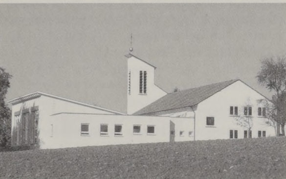
In Form eines Anbaus an die Pauluskirche hat die Gemeinde Maubach ein Gemeindehaus bekommen.
