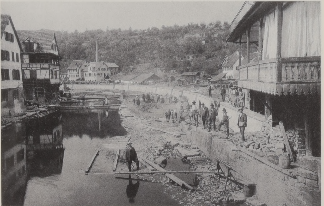
1. Murrkorrektur im Jahr 1904 unterhalb der Sulzbacher Brücke.
