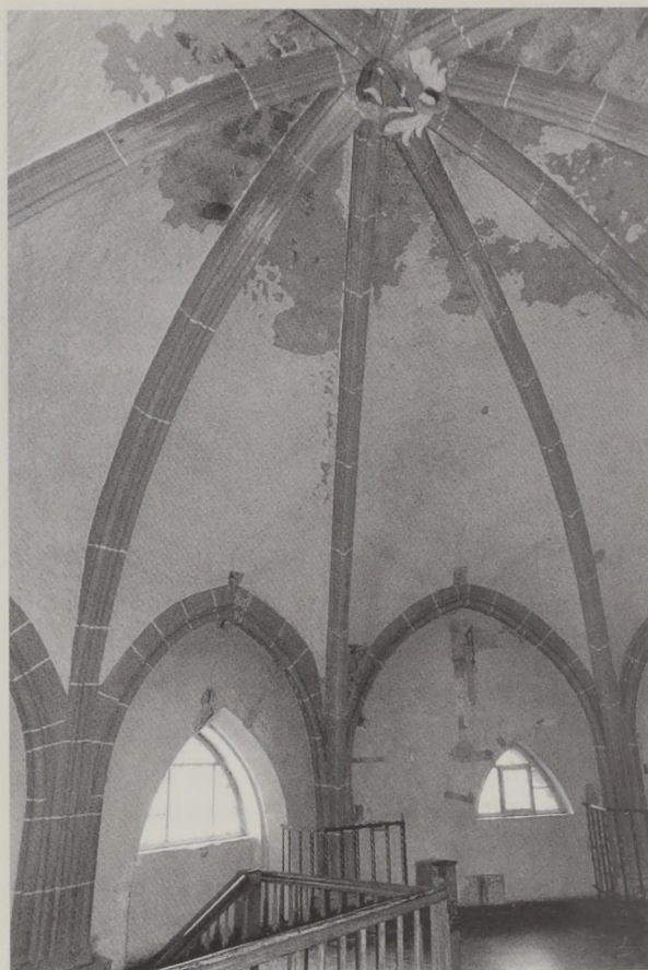
Beginn der Renovierungsarbeiten im gotischen Chor der Michaelskirche.
