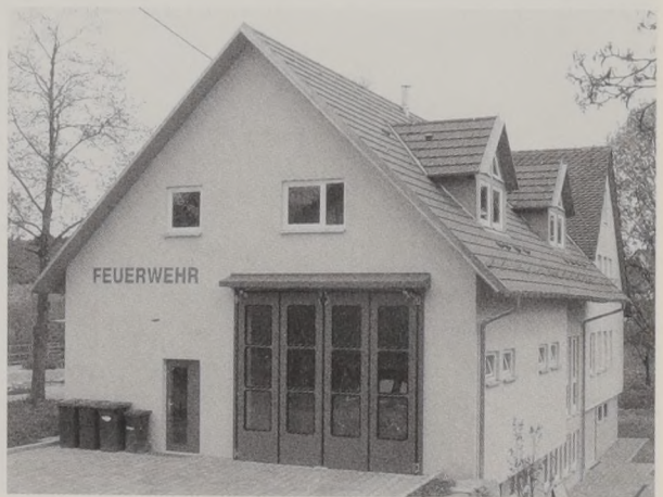
Der Zugang zum neuen Feuerwehrgerätehaus in Strümpfelbach erfolgt von der Rückseite des Rathauses.
