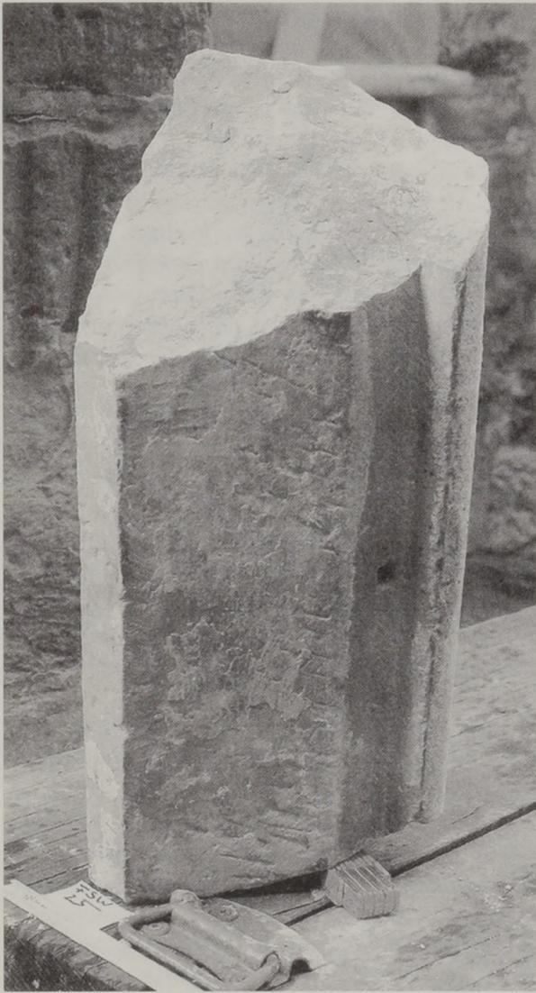
Abb. 6: FSW 25 – Stabwerkteile, 13. Jh., Schilfsandstein, an der Schmalseite vor dem Fensteranschlag Vertiefungen für Windeisen, an einer Seite viereckige Aussparung (1,5 x 1,5 cm, Tiefe mind. 2 cm), an der anderen Seite Vertiefung jeweils mit schleifender Rille zum Einschleiben des Eisens.
