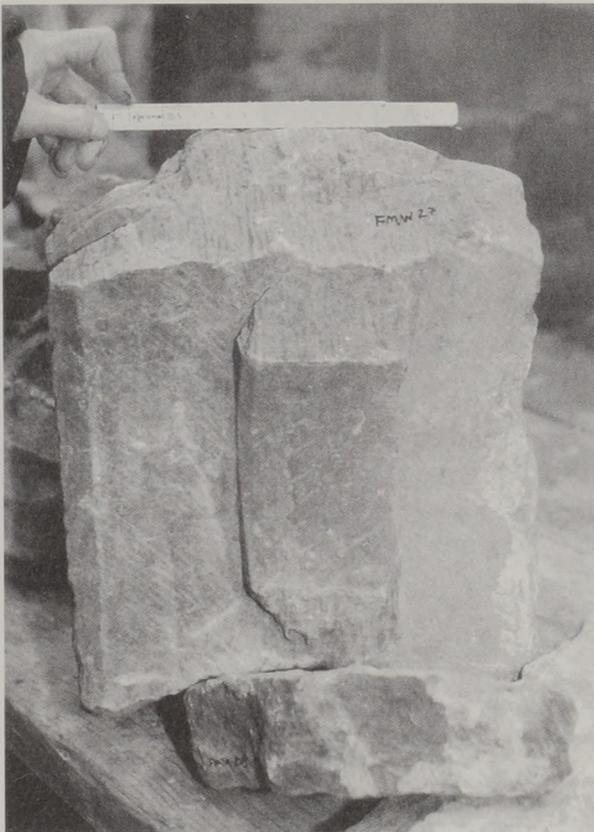
Abb. 9: FMW 27 – Maßwerksegment, 13. Jh., rot gefleckter Schilfsandstein, originale Tiefe mit Rippenansatz an beiden Seiten erhalten (32 cm). Anlauf eines inneren Couronnements (10 cm breit) Rückseite grob abgespitzt – Anschluss an äußeres Gewände.
