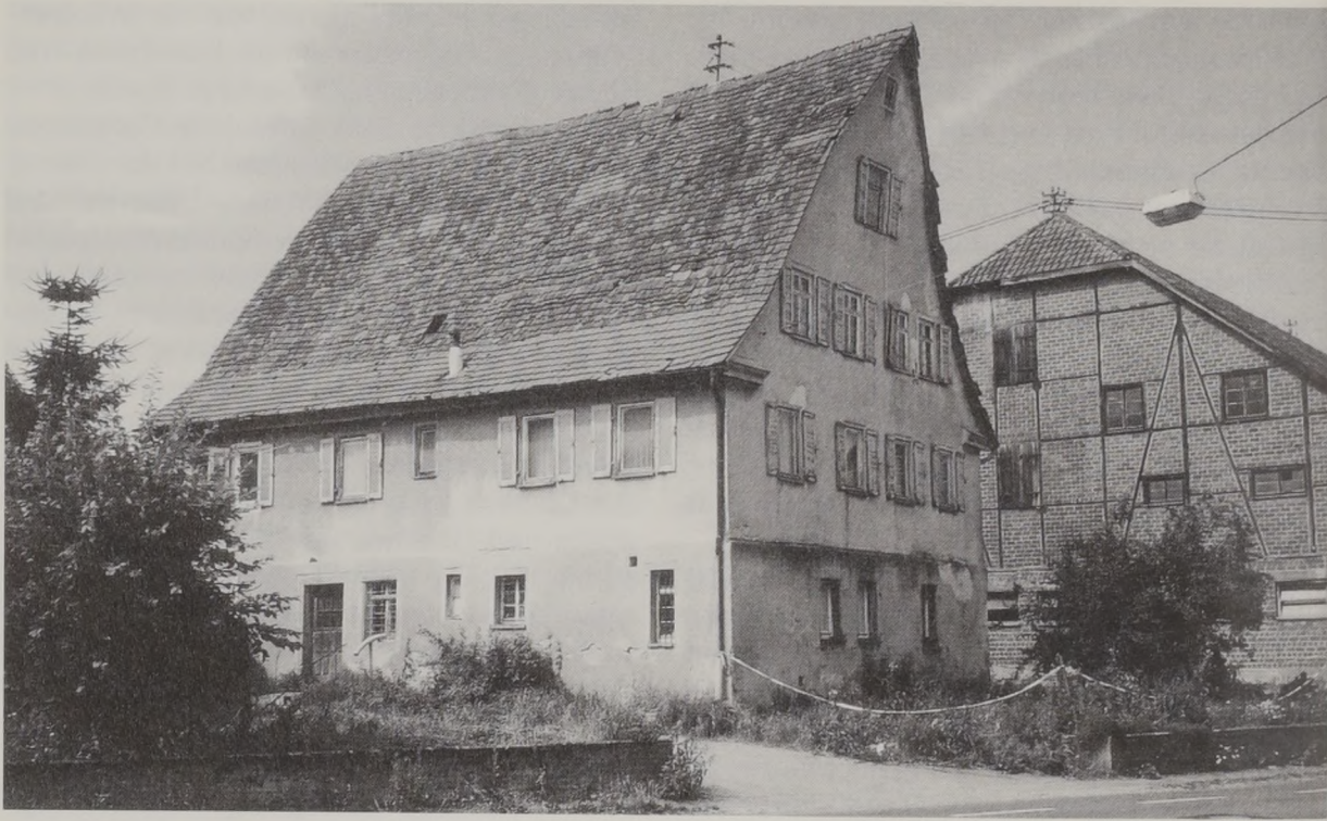
Abb. 42: Das Stammhaus der Familien Metzger im Ungeheuerhof. Foto: 2003, kurz vor dem Abbruch.
