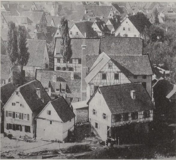
Abb. 26: Ausschnitt vom Biegel im hinteren Bereich, Foto von 1874. Hinter der Gebäudegruppe der Lederfabrik Carl Kaess (zweite und dritte Reihe), ist rechts das Gebäude 570 von Friedrich Kaess zu sehen. Vorn (rechts) die 1850 errichtete neue Lohmühle.
