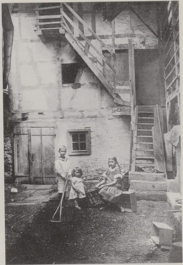
Abb. 21: Das Anfang der 1920er Jahre entstandene Foto zeigt den Innenhof vom Gebäude Biegel 24 mit dem außen angebrachten Treppenaufgang zu den oberen Geschossen.
