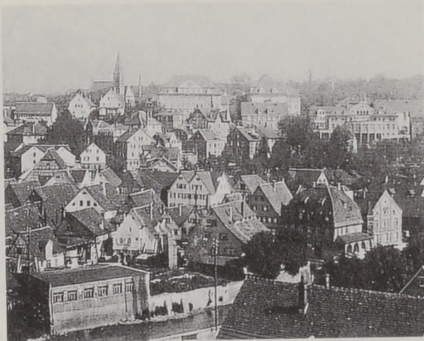
Abb. 15: Nach dem Brand vom 15. März 1916 war neben dem massiven Erdgeschoss des Fabrikgebäudes nur noch das Wohnhaus und der Neubau für die Chromgerbung (vorn, links) übriggeblieben. Foto um 1924.
