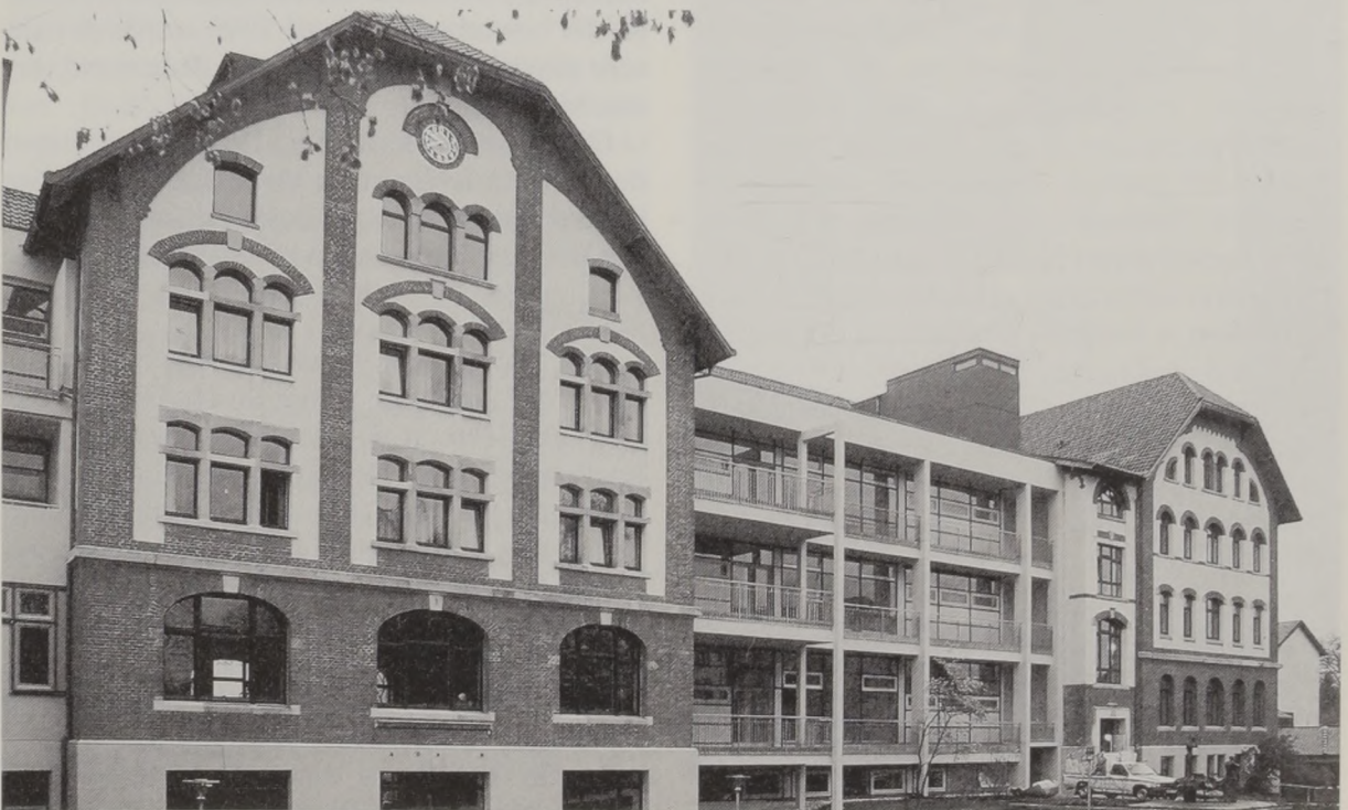
Sehr aufwändig und liebevoll wiederhergestellt: die Fassade des Hauptgebäudes mit dem zweiten Bauabschnitt des Alten- und Pflegeheims Staigacker.
