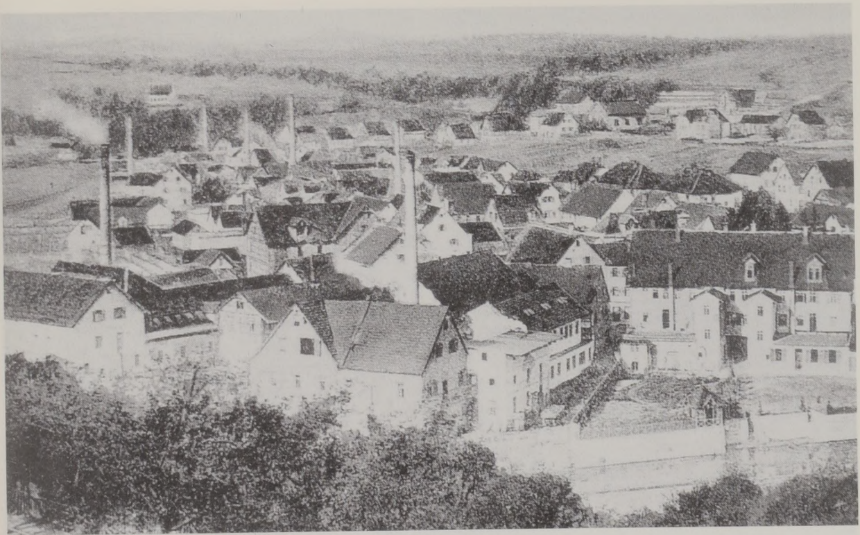
Abb. 28: Aufnahme der Fabrikanlage Gerberstraße 31/33 um 1903 mit dem 1893 errichteten neuen Schornstein aus Richtung Bahnhofstraße.
