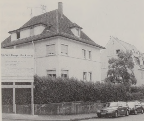
Beginn der Umbauarbeiten des Gebäudes Krankenhausweg 10 zum Backnanger Hospiz.
