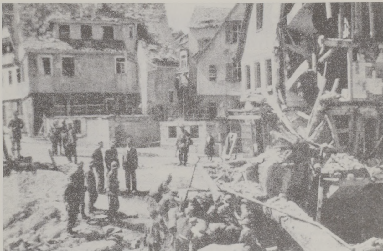
Die Sulzbacher Brücke war nach der Sprengung durch die deutsche Wehrmacht nur nach unten abgesackt und konnte von den amerikanischen Truppen relativ schnell wieder so hergestellt werden, dass sie befahrbar war. Im Hintergrund sind die erheblichen Schäden an den Nachbargebäuden zu sehen, die bei der Sprengung der Brücke entstanden.
