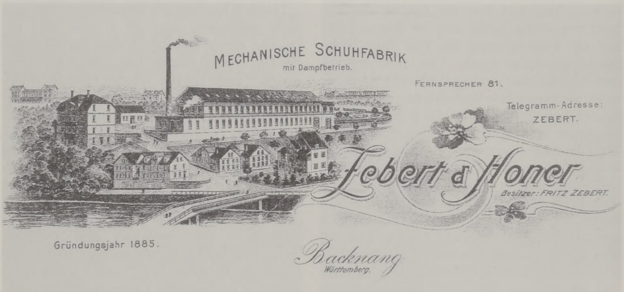
Abb. 50: Auf der Visitenkarte der Firma Zebert & Honer ist auch die von Gottlob Häuser begonnene Ansiedlung am Etwiesenberg zu sehen. Stand 1910.
