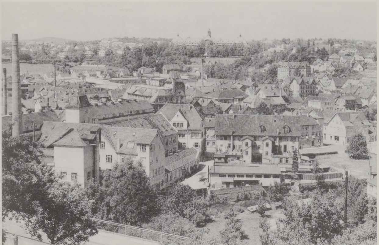
Am 1. September 1946 eröffnete der Elektrokonzern AEG in den ehemaligen Gebäuden der Lederfabrik Fritz Häuser in der Gerberstraße (Fabrikgebäude am linken Bildrand) einen Reparaturbetrieb für Kühlschränke. Am 1. November d. J. folgte die Abteilung Fernmeldetechnik nach und begründete damit einen Wirtschaftszweig in Backnang, der heute noch zu den wichtigsten zählt.
