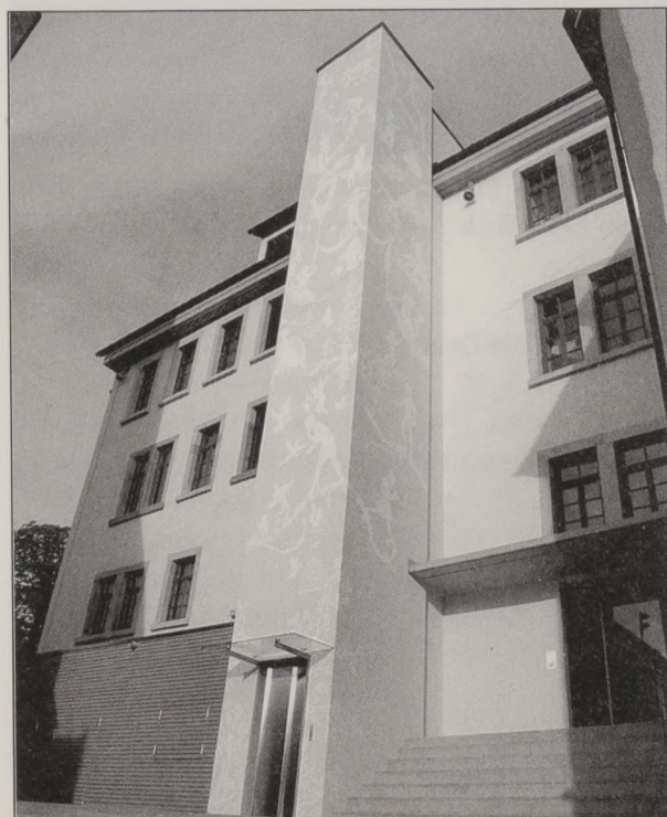
Ist ein Hingucker: Der Fahrstuhlschacht am Bandhaus mit den Verzierungen der Künstlerin Saskia Schultz.
