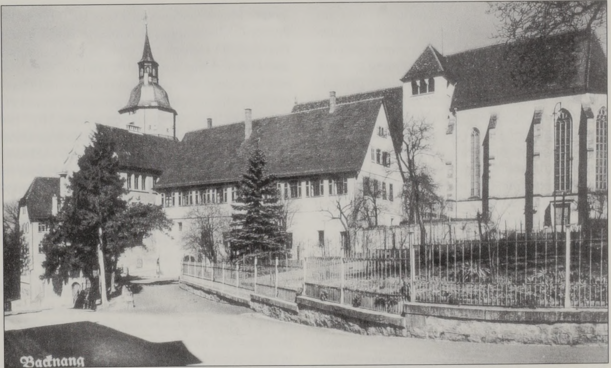
Nach der Reformation zog der evangelische Stadtpfarrer ins Refektorium des ehemaligen Augustiner-Chorherrenstifts ein. Nach dem Stadtbrand von 1693 wurde das Gebäude neu errichtet und seitdem als Dekanat genutzt (Aufnahme von 1934).
