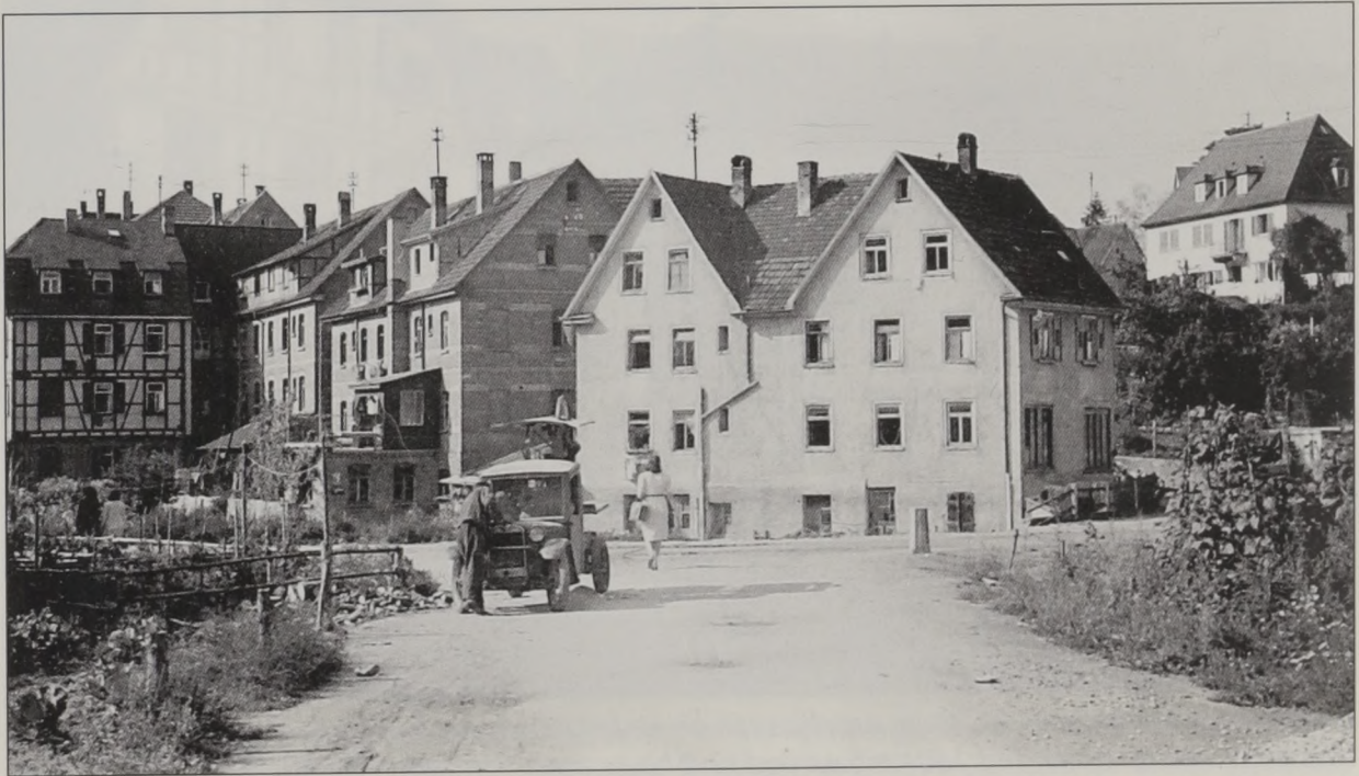
Gebäude Gartenstraße 40 bis 52 aus einem anderen Blickwinkel. Im Hintergrund das Gebäude Rosenstraße 12. Der Weg, auf dem der Fotograf stand, führte zur Murr und dann zu den Gebäuden in der Oberen Walke.
