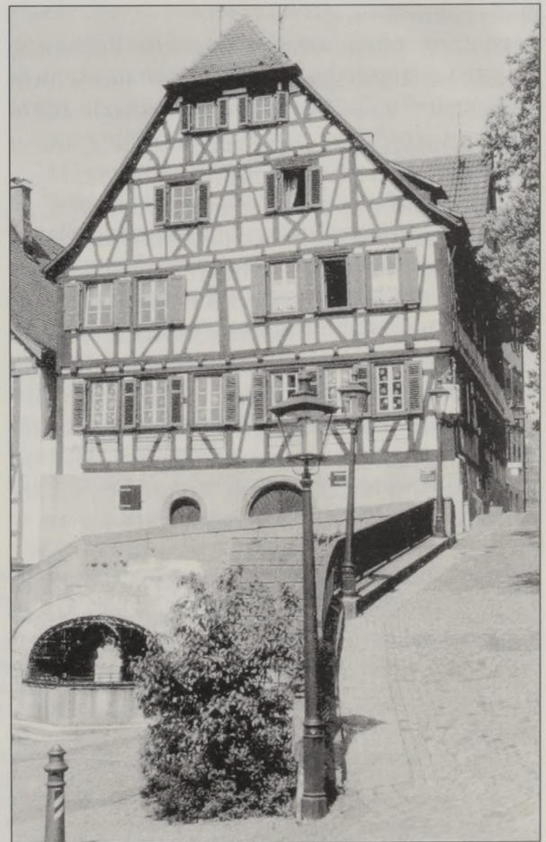
Im Gebäude Ölberg 10 waren bis ins frühe 19. Jahrhundert sowohl die Lateinschule als auch die Deutsche Schule untergebracht (Aufnahme von 1990).
