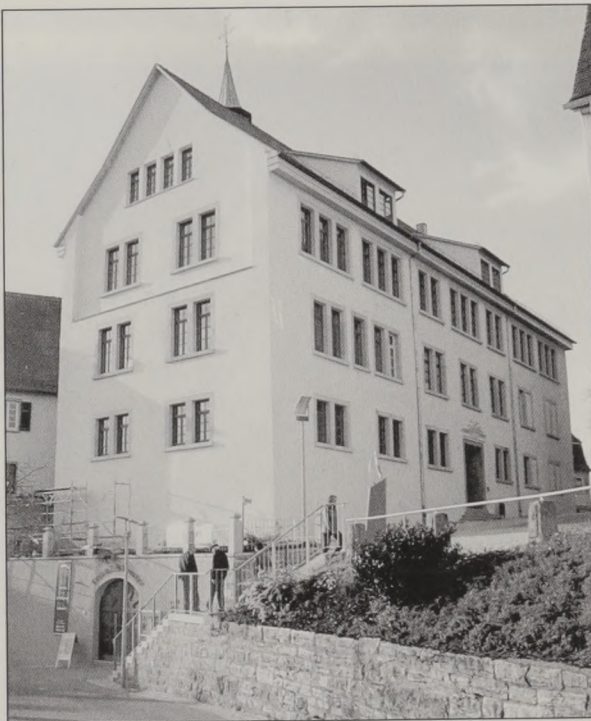
Das aufwendig sanierte Bandhaus ist künftig das Zuhause der Backnanger Jugendmusikschule.
