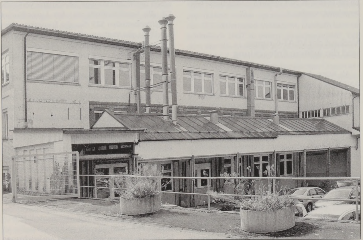
Im Gebäude Wilhelmstraße 43 war die VSAT-Gruppe nach ihrer Ausgliederung aus der Raumfahrt-Abteilung untergebracht.
