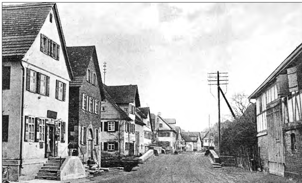
Blick entlang der Hauptstraße von Großaspach.
