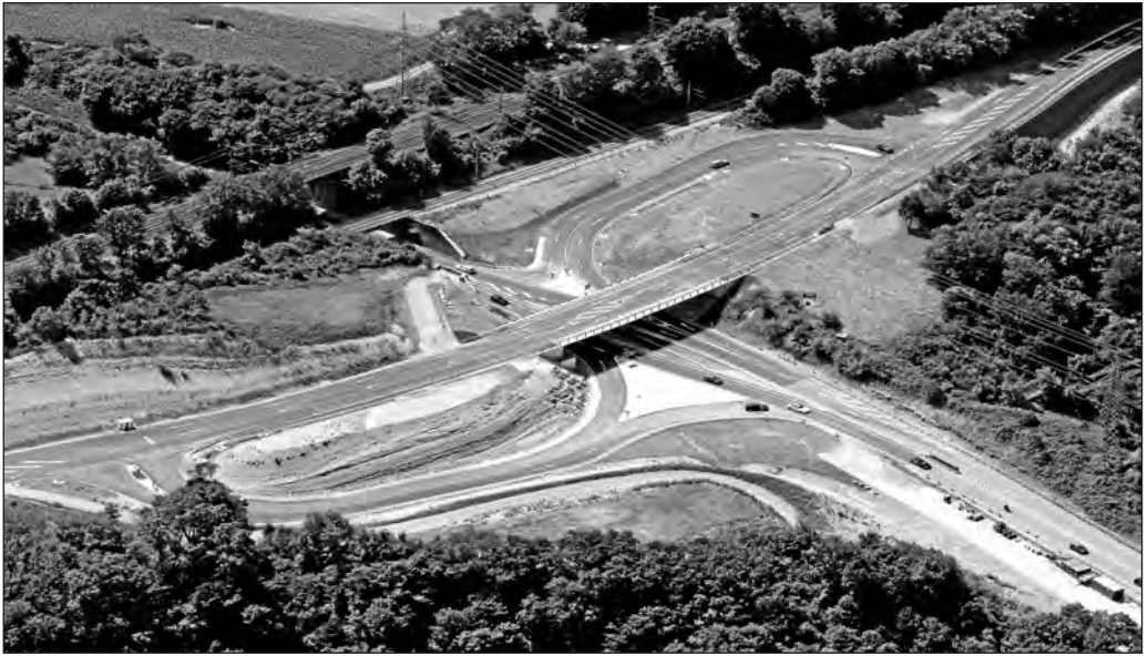
Die neue B-14-Anschlussstelle Backnang-Mitte aus der Vogelperspektive.
