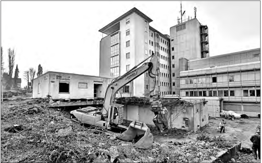
Es verschwindet ein Stück Backnanger Geschichte: Beginn der Abbrucharbeiten am ehemaligen Kreis- krankenhaus.
