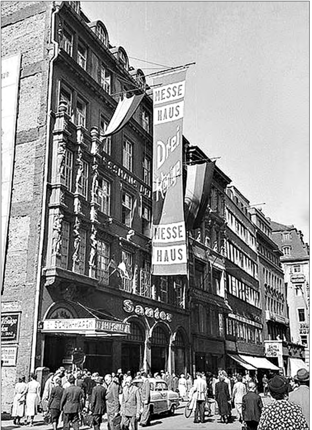
Das während des Ersten Weltkriegs fertiggestellte Messehaus „Drei Könige“ in Leipzig (Aufnahme von 1953).
