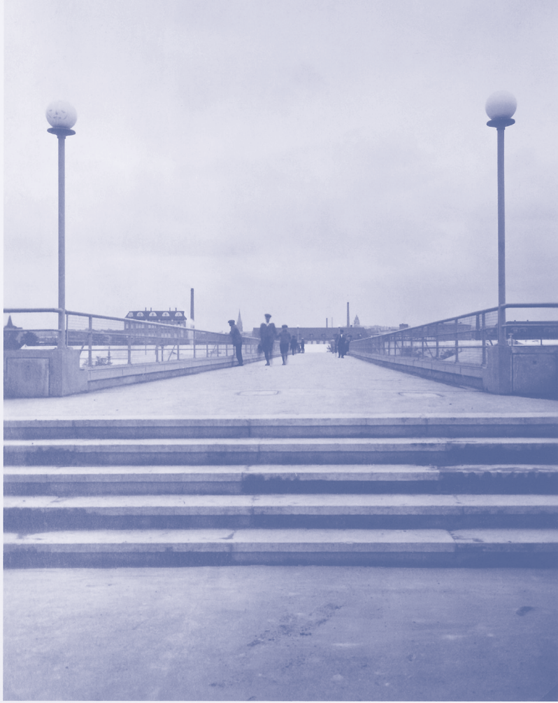
Der Berger Steg, die „Orwell Bridge“ in Stuttgart, vor 1945
