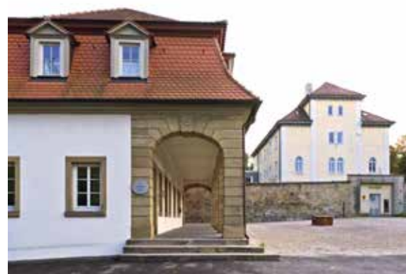
Dienstgebäude und Torhaus in Ludwigsburg
