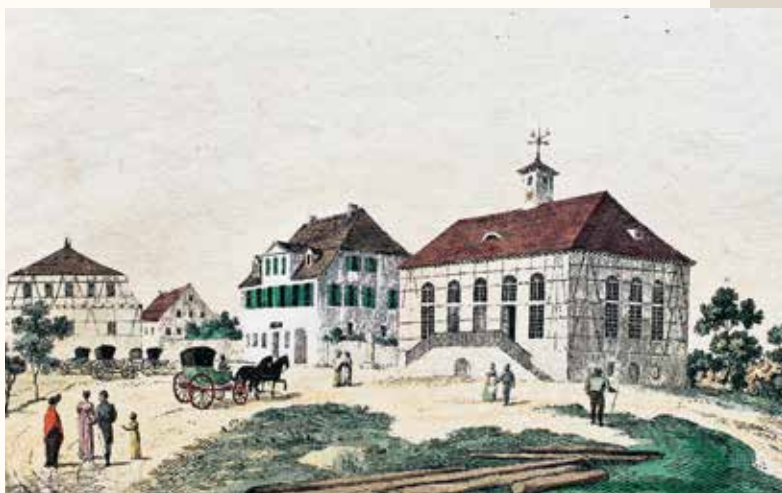
Abb. v.l.n.r.: Korntal von Süden, um 1820 | Korntal von Südosten, um 1820 | Heutiger Saalplatz mit Kelter, Gemeindegasthaus und Betsaal, um 1820 | Betsaal, im Hintergrund Gemein- degasthaus, links Pfarrhaus, um 1840
