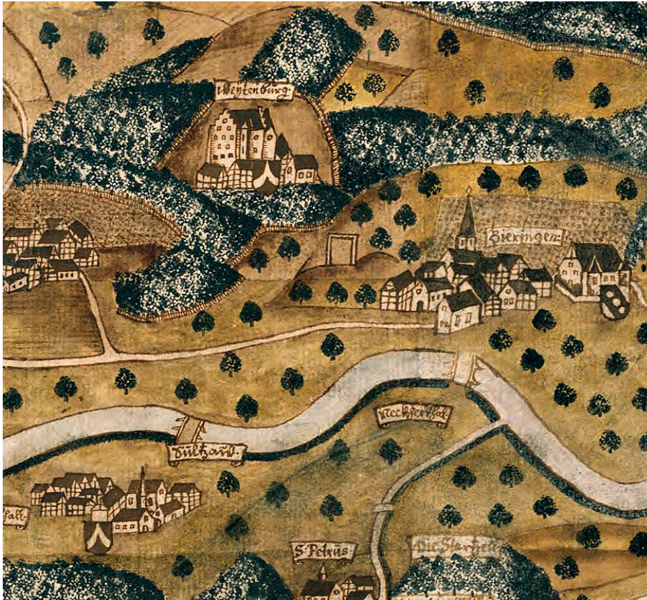
Karte der Gegend am oberen Neckar von Johann Ulrich Stierlin (1705, Ausschnitt). Unter der Bezeichnung »Weytenburg« erkennt man den noch heute vorhandenen »Ehinger Bau« und Gebäude der Vorburg. Jenseits des Neckars liegt Sulzau, besitzrechtlich mit der Weitenburg stets eine Einheit. Die beiden Wappen stehen für die Herren von Ethingen, die Sulzau und die Weitenburg schon 1613 an Württemberg verkauft. Stierlin hat für seine Karte also wohl auf ältere Vorlagen aus der Zeit kurz nach 1600 zurückgegriffen.
