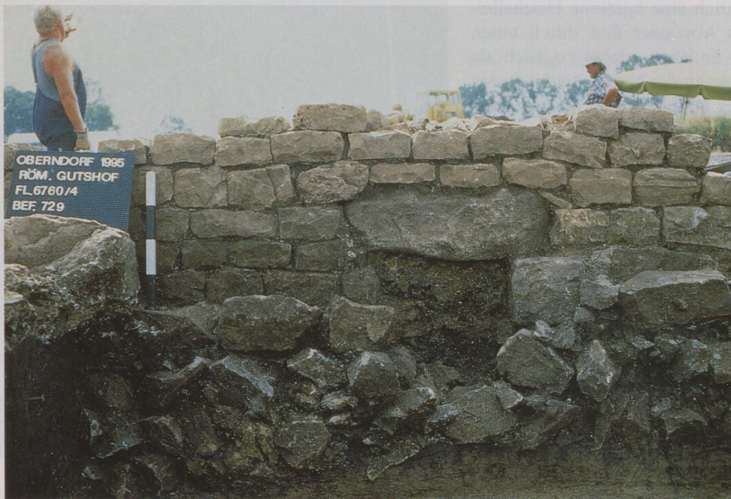
Mit Erde verstopft ist der Mauerdurchlaß für die Wasserleitung ins Bad.
