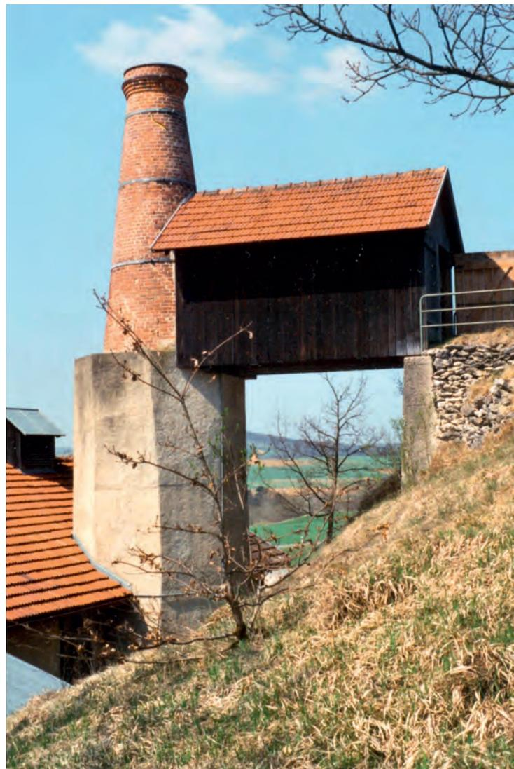
*Die bei der Sanierung 1986 erneuerte Gichtbrücke, in die mit Kipp-Loren eingefahren werden konnte.*
