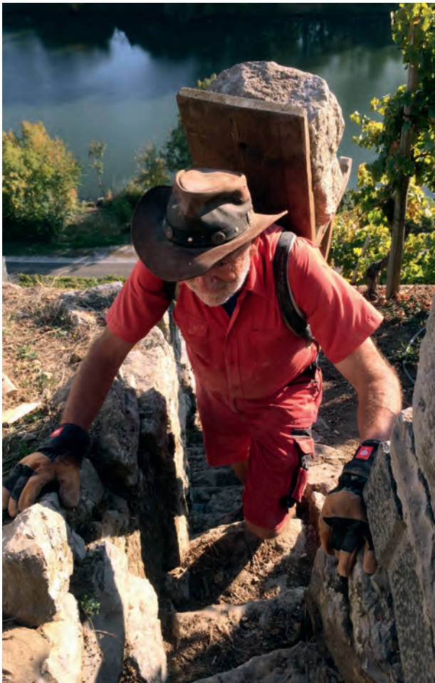
Die mächtigen, fachgerecht mit Hintergemäuer aufgebauten Trockenmauern sind zu einem Blickfang am Wurmberg geworden. Der Transport der schweren Muschelkalksteine ist echte Knochenarbeit.
