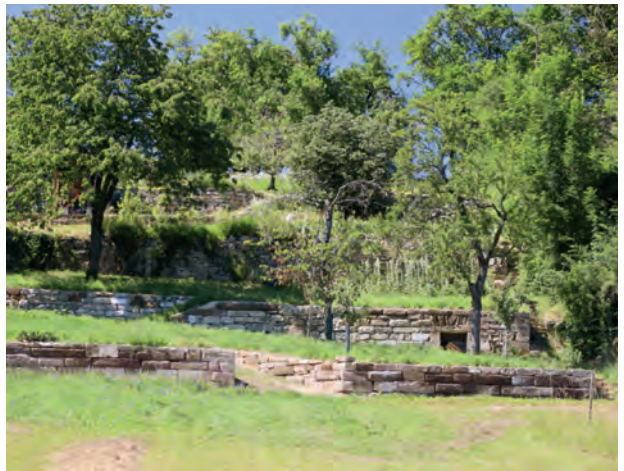
Die mächtigen, fachgerecht mit Hintergemäuer aufgebauten Trockenmauern sind zu einem Blickfang am Wurmberg geworden. Der Transport der schweren Muschelkalksteine ist echte Knochenarbeit.
