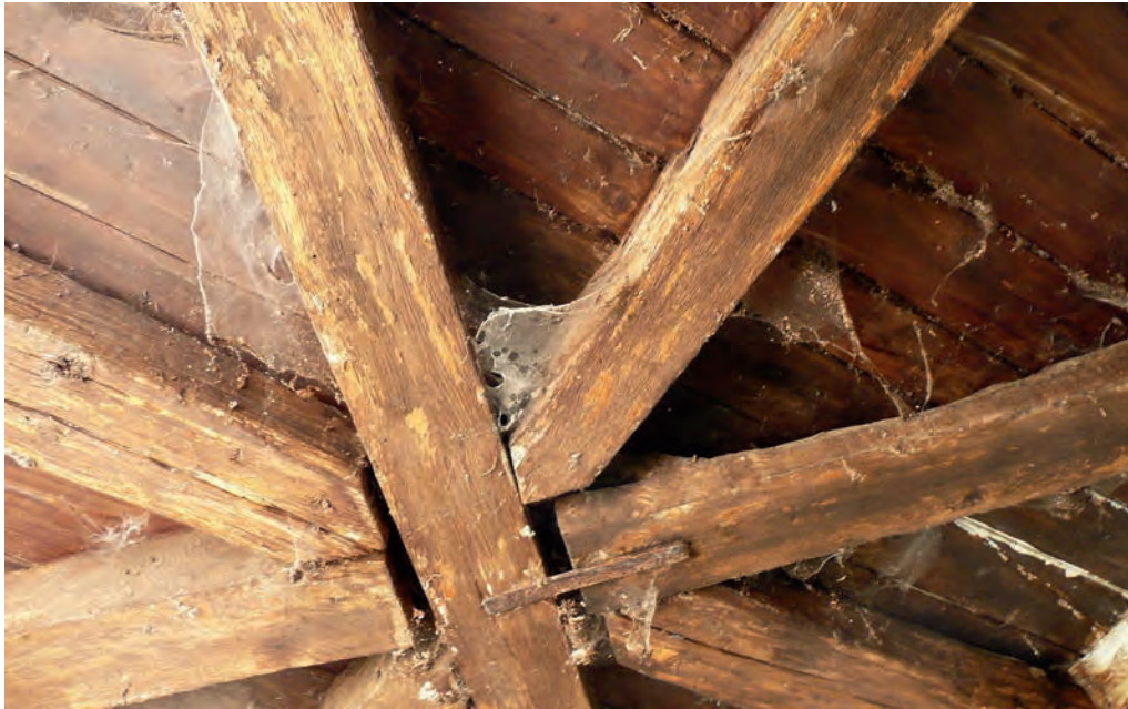
An drei Balken im Innern des Häuschens konnten bei den Renovierungsarbeiten Spuren einer roten Fachwerkausmalung nachgewiesen werden. Leider sind sie nur fotografisch dokumentiert. Foto vom 3. März 2016.
