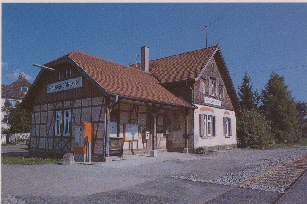
Bahnhof Haubersbronn, eines der denkmalgeschützten Bahnhofsgebäude entlang der Strecke Schorndorf–Welzheim, die alle gleich gestaltet sind.
