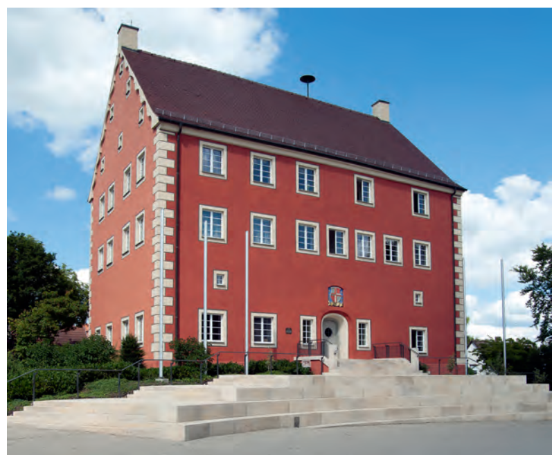
Auch im Oberen Donautal führt in der Frühen Neuzeit der Weg fort von den ebenso kühnen wie unbequemen Felsenburgen und hin zu repräsentativen Schlössern wie dem der Herren von Hausen in Stetten am kalten Markt aus der Zeit um 1555.
