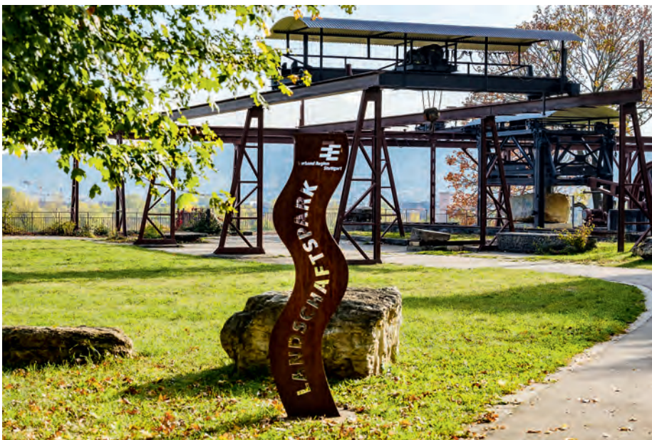
Der 2010 und 2014 in zwei Abschnitten eröffnete «Travertinpark» – hier die Krananlagen des Steinbruchs Schaufele – ist ein einzigartiges Natur- und Technikenkmal. Er bleibt ohne das Lauster-Areal allerdings Stückwerk.
