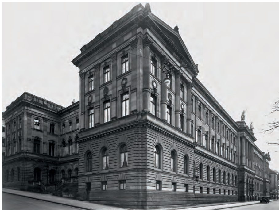
Das frühere Justizgebäude an der Urbanstrasse (1878–1944). Hier tagten das Sondergericht und das Oberlandesgericht; auch der Berliner Volksgerichtshof hielt hier auswärtige Sitzungen ab.
