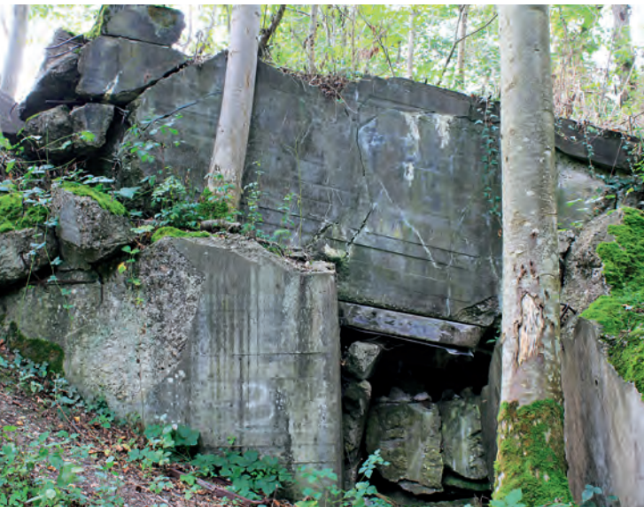
Gesprengrter Westwallbunker der so genannten Korker Stellung bei Kehl am Oberrhein.
