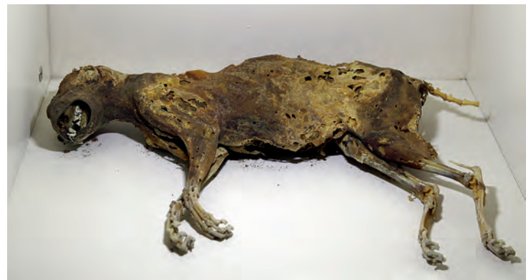
Die mumifizierte Katze lag jahrhundertlang in der Hohldecke über dem ersten Stock im Bönningheimer Meiereihof 5, erbaut 1463. Vermutlich stammt die Katze aus der Bauzeit. Katzen galten als Hexensymbole, hier deponiert, um Hexen fernzuhalten.
