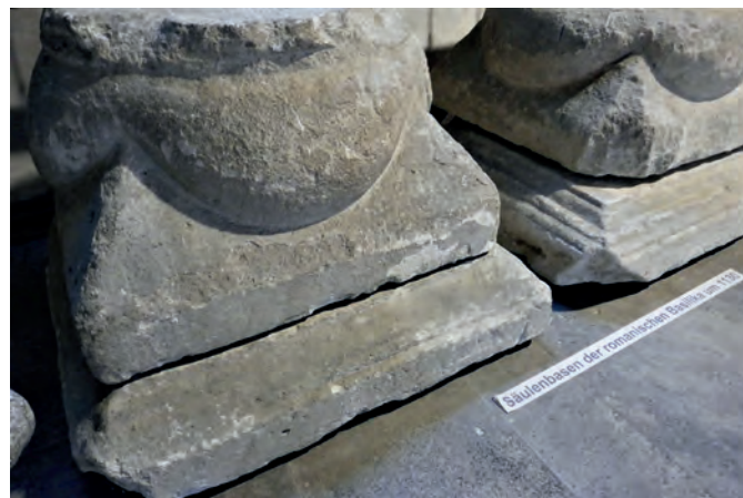
Ausgrabungen 1963 in der Martinskirche: Säulenbasen mit Eckhülsenpolstern und Basisplatten. Zumindest bei der rechten handelt es sich um eine Kämpferplatte mit schräg gestaffelter Profilierung. Diese wurden auf den Säulenkapitellen, nicht unter den Säulenbasen eingebaut, deshalb ist es eine Spolie.
