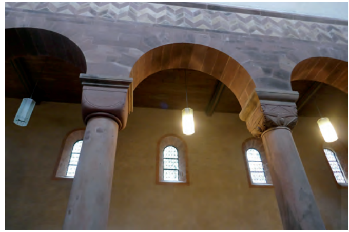
... und romanische Kapitelle mit »Kämpferplatten« und typischen Zierprofilen im Langhaus der Klosterkirche Alpirsbach, erbaut um 1130
