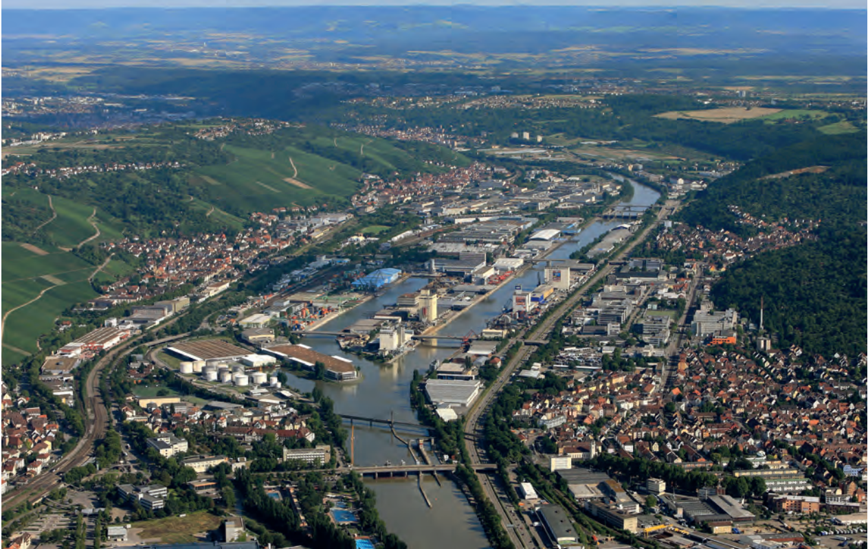
Von den insgesamt 367 Kilometern Flusslauf wurden 188 ausgebaut und für die Schifffahrt nutzbar gemacht. Der Umbau zum Kanal begann 1935 zwischen Mannheim und Heilbronn und wurde 1968 mit der Eröffnung des Plochinger Neckarhafens beendet. Zwischen Stuttgart und Esslingen gibt es noch Wald und Weinberge – dazwischen zwängen Eisenbahn und Bundesstraße den Neckar in sein künstliches Bett.
