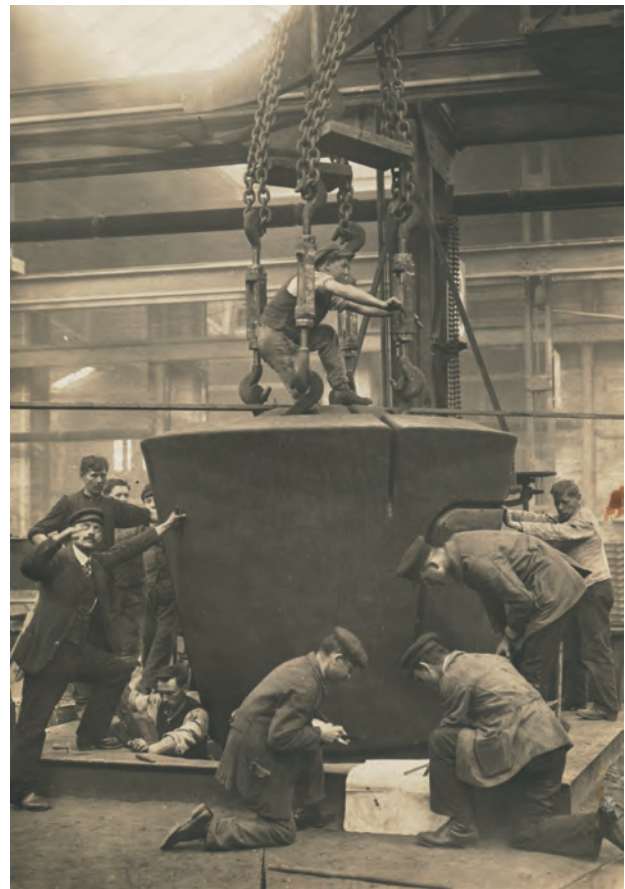
In der Gießerei Wasseraffingen posieren Arbeiter 1923 im Großgussfeld an einem Turbinenteil.
