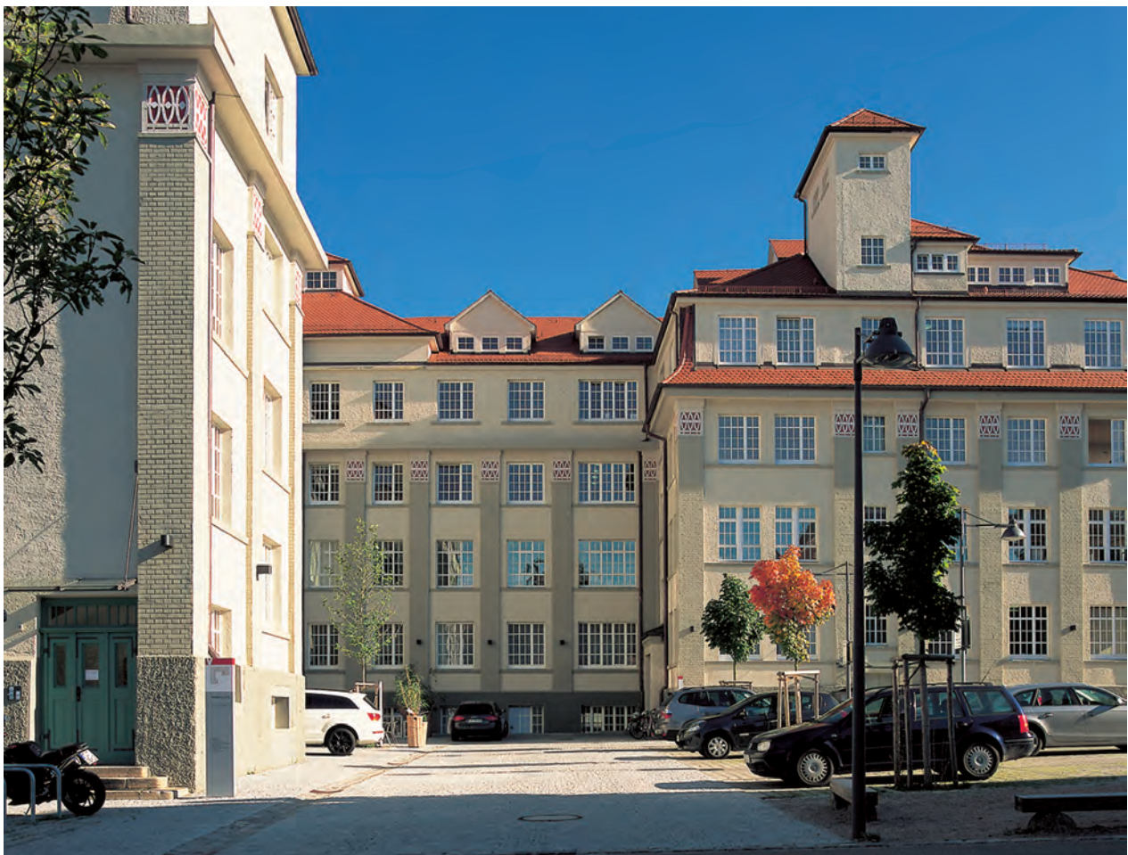
Der Bau V der früheren Hohner-Werke in Trossingen von Philipp Jakob Manz ist nach der Sanierung wieder ein ansehnliches Industriedenkmal und gleichzeitig ein Ort urbanen Lebens geworden.
