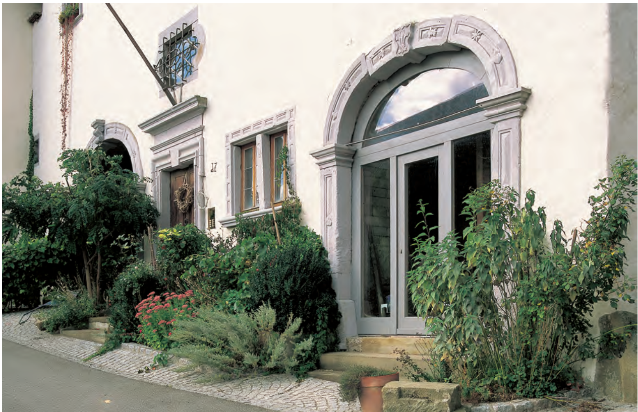
In der Außenmauer des Hauptbaus zeugen Gewände aus Renaissance und Barock von einer wechselvollen Baugeschichte des Oberen Schlosses.
