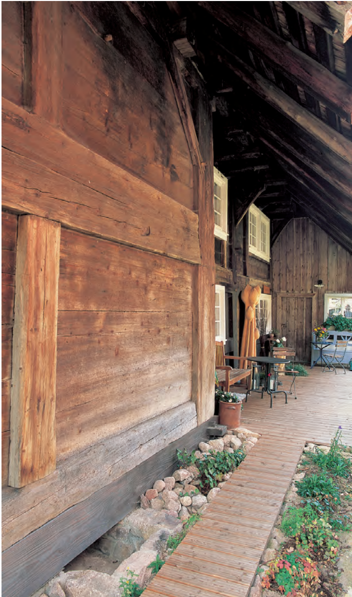
Die an der Eingangsseite des Franz-Seppe-Hofs sichtbar gebliebene Ständerbohlenkonstruktion aus dem 18. Jahrhundert beeindruckt durch ihre ungemein massiven Dimensionen. Der Schwellriegel wurde vorbildlich erneuert.
