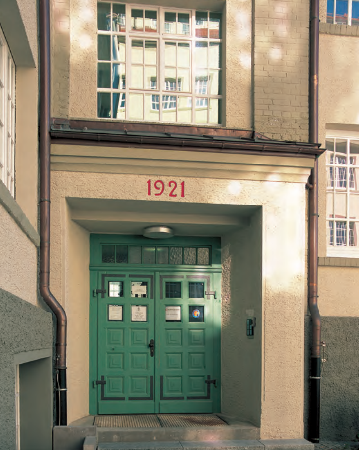
Vorbildlich restauriert in den Details – der Trossinger Fabrikbau mit originalen Türen und Fenstern.
