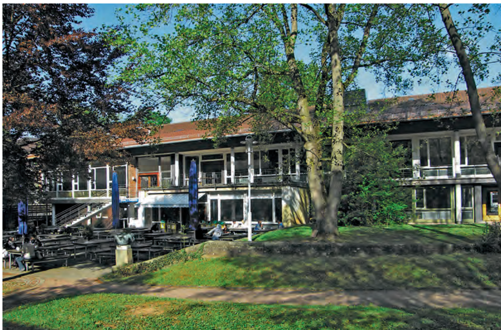
Rückfassade des Clubhauses an der Tübinger Wilhelmstraße, in den 1950er-Jahren erbaut von Rolf Gutbrod.
