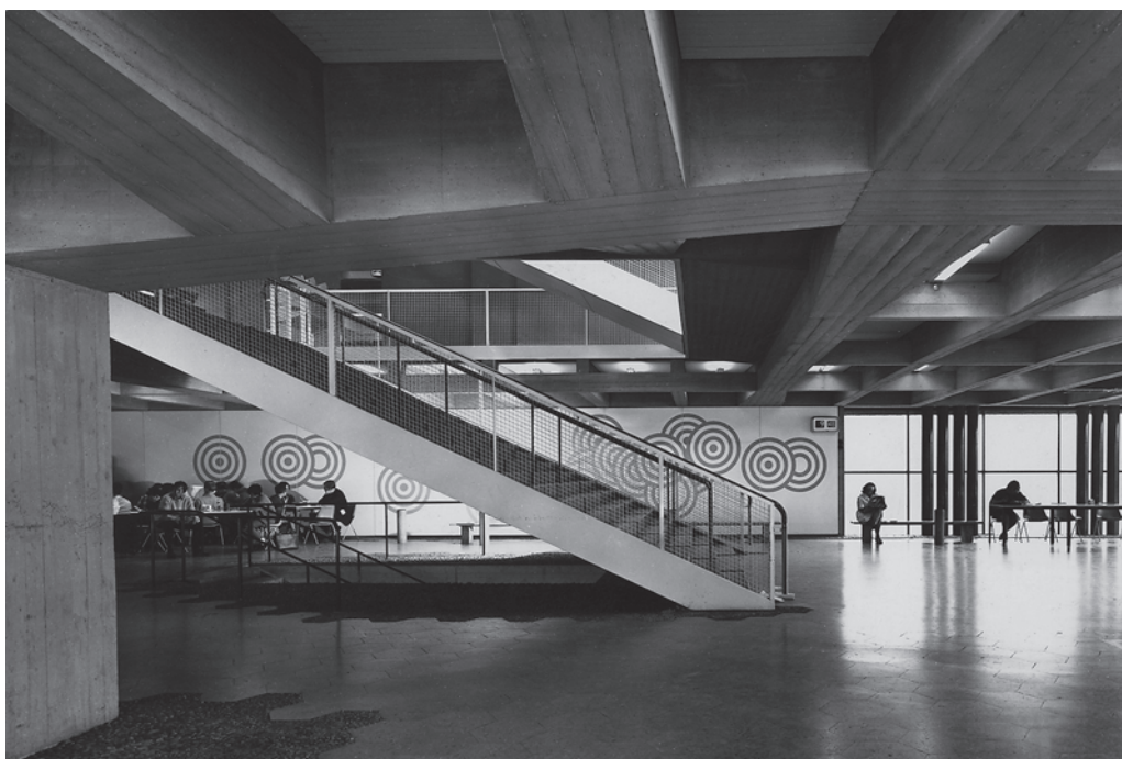
Die Innentreppe der Tübinger Mensa.
