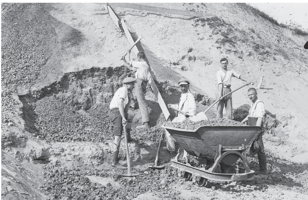
Der Abbau des Knollenmergels ist eine Knochenarbeit. Hier schaufeln Arbeitskräfte den Abraum in eine Lore (1932).
