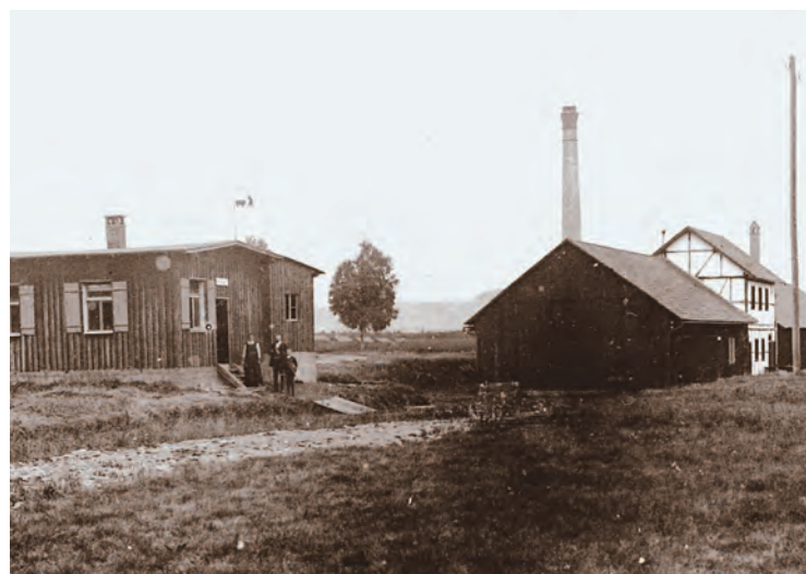
Kantine und neue Torfstreu fabrik des «Zeiler» Werks, vermutlich 1914, mit Kantinewirtin Antonie Mahler und Familie. Deutlich zu sehen ist das Torfwerk und der hohe Kamin für die Dampfmaschine.
