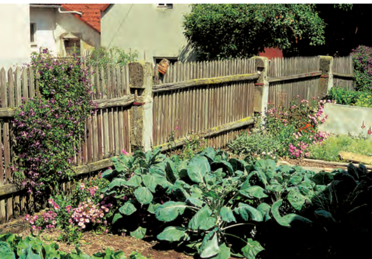
Solche Zäune mit Sandsteinpfosten und Lattenfeldern zum Einhängen sind für hohenlohische Gärten immer noch typisch und verdienen es, erhalten zu werden.
