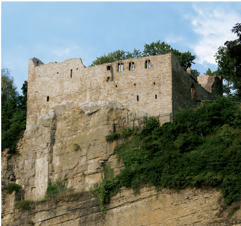
Hoch über der Enz erhebt sich auf einem steil abfallenden Felsen die Burgruine Löffelstelz, nicht weit entfernt von Mühl- acker.
