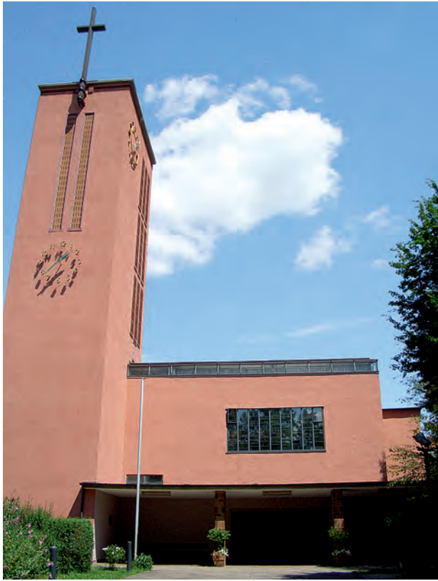
Evang. Kreuzkirche in Stuttgart-Hedelfingen, erbaut von den Architekten Volkart und Trüdinger, heutige Ansicht.
