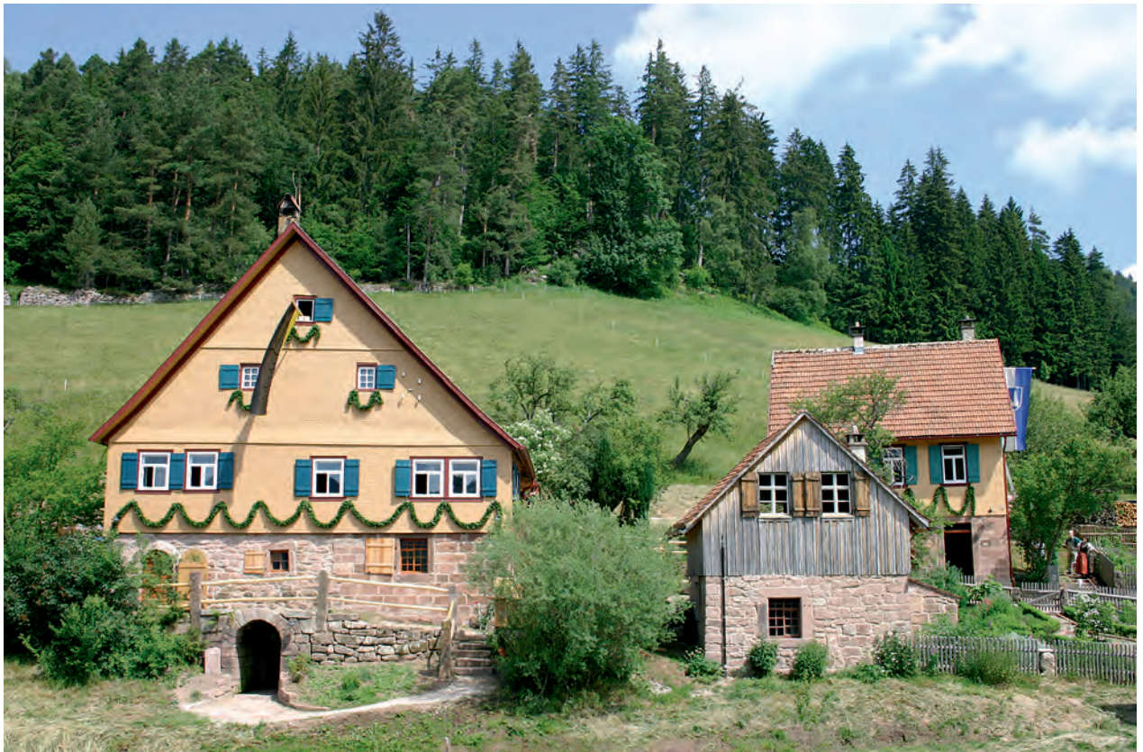
Das restaurierte Ensemble des Morlokhofs mit Hauptbau, Back- und Austragshaus hoch über dem oberen Murgtal.
