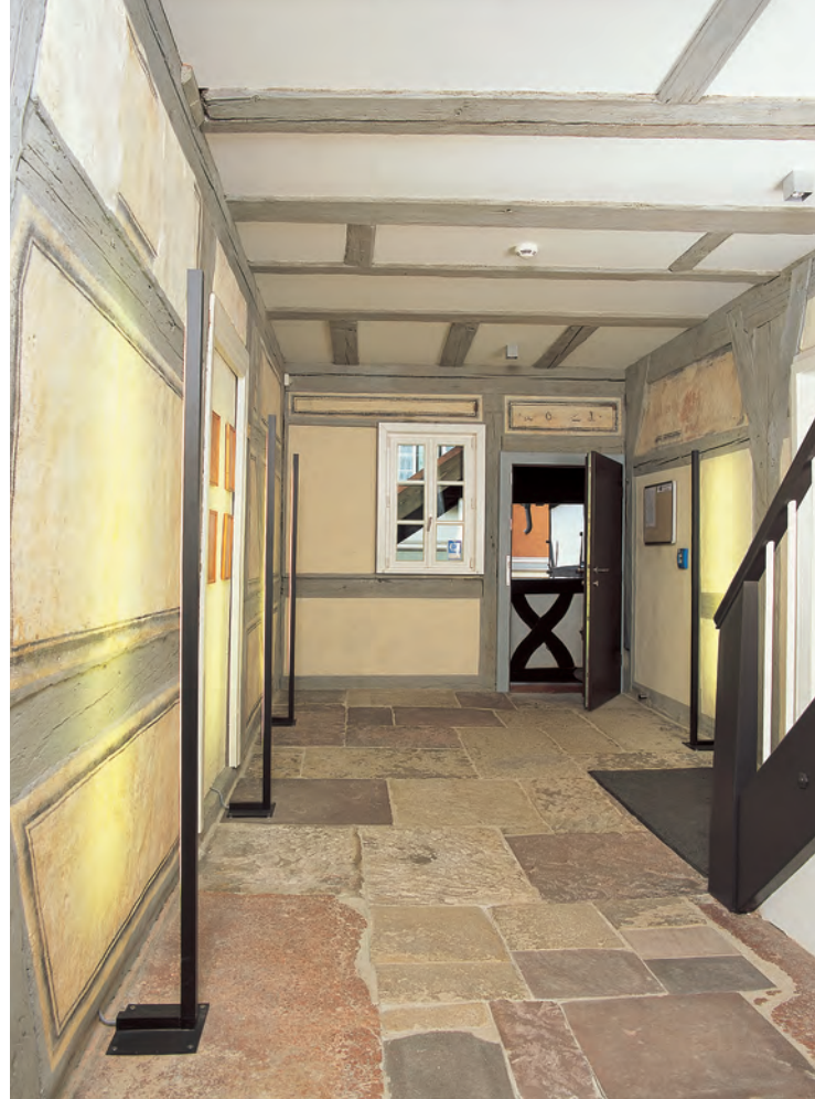
Der Mittelflur im ersten Obergeschoss des Nonnenhauses mit freigelegten Malereifragmenten des frühen 17. Jahrhunderts.
