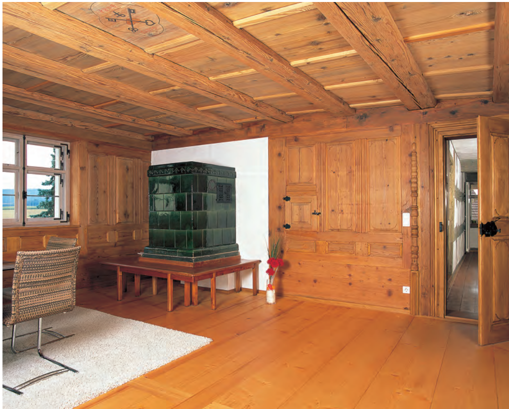
Die große Stube des «Götzhauses» mit reparierter bauzeitlicher Holztäferung und altem Kachelofen.
