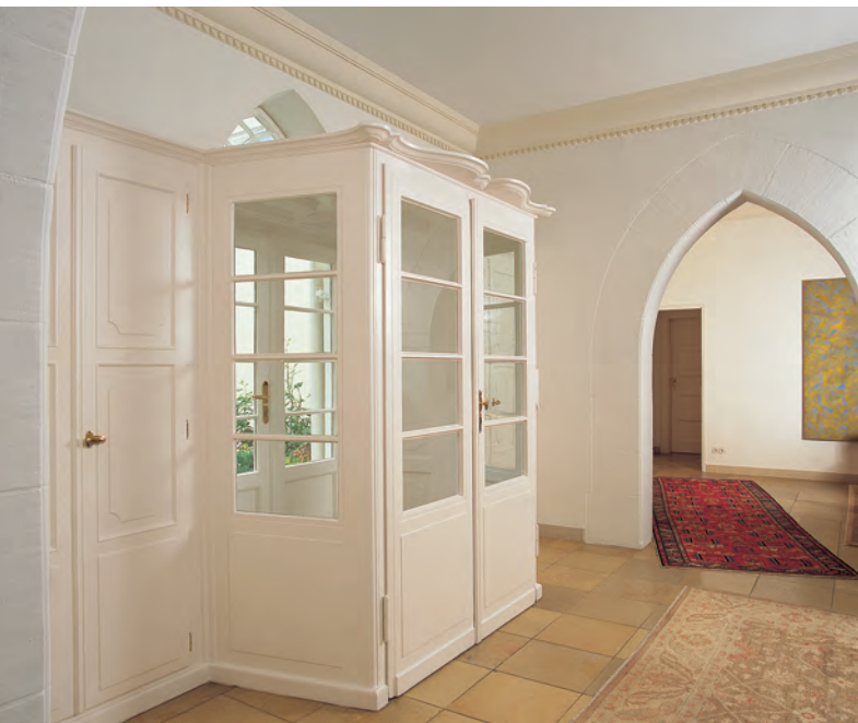
Vorbildliche handwerkliche Reparatur der Originalausstattung der Villa Kahn. Hier der Windfang in der Eingangshalle.
