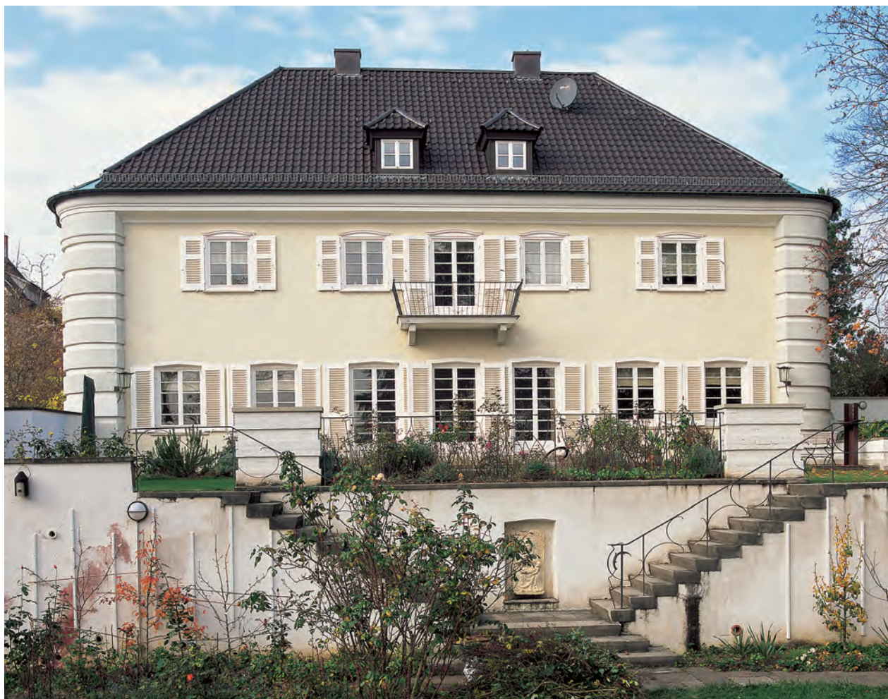
Haus und architektonisch gegliederter Garten, der wieder hergestellt wurde, bilden bei der Villa Kahn eine Einheit.
