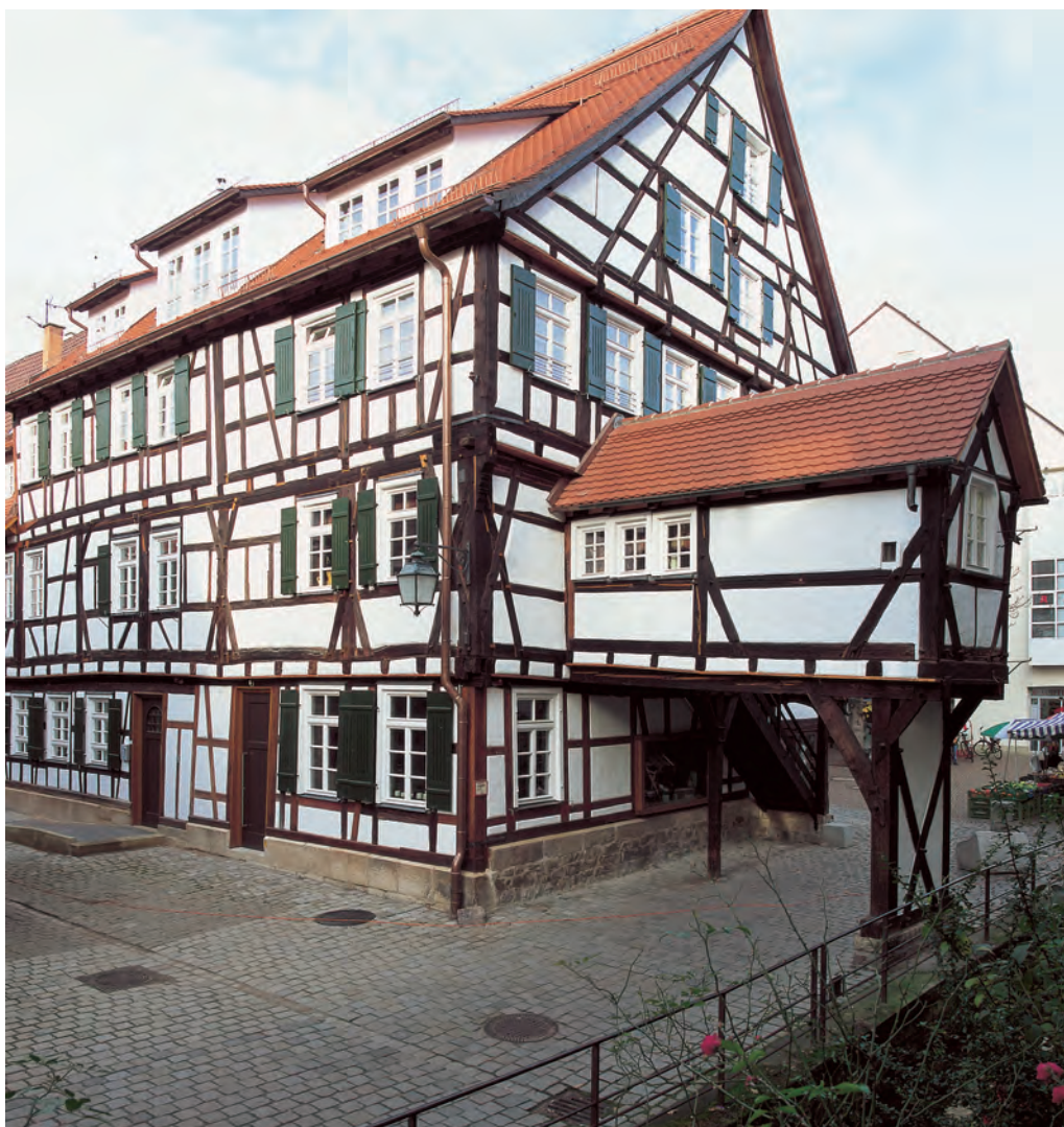
Das nach neuesten energetischen Gesichtspunkten sanierte ehemalige Nonnenhaus in Tübingen. Vorne das zum Ursprungsbau gehörende «Sprachhaus», ehemals der Latrinenanbau am Ammerkanal.
