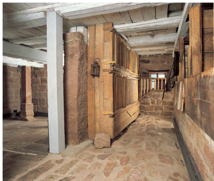
Im Sockelgeschoss des Morlokhofs sind sogar noch die originalen Stalleinbauten für Hühner und Kühe erhalten.
