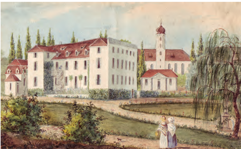
Rückfront des Schlosses Inzigkofen inmitten des klar gegliederten Schlossgartens, im Hintergrund die ehemalige Klosterkirche. Das Wachhaus davor steht auf der Flucht der hier abgebrochenen Klausurmauer.
