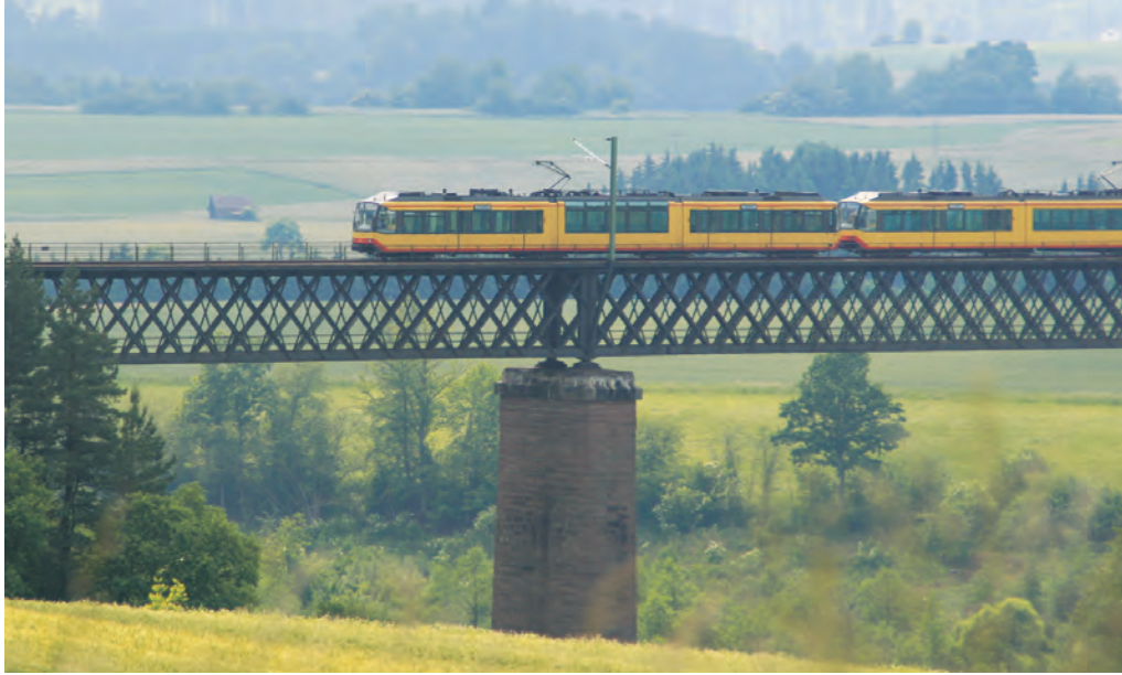
Triebwagen der Altal-Verkehrs-Gesellschaft auf dem Kübelbach-Viadukt bei Dornstetten-Aach.
