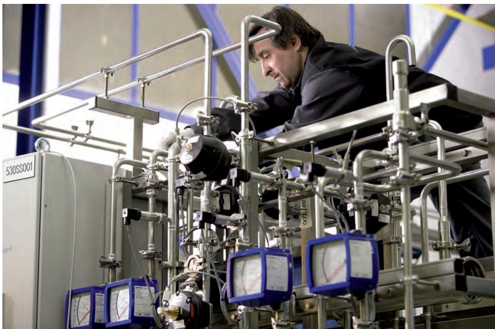
So wird heute in der Firma Hager + Elsässer gearbeitet.
