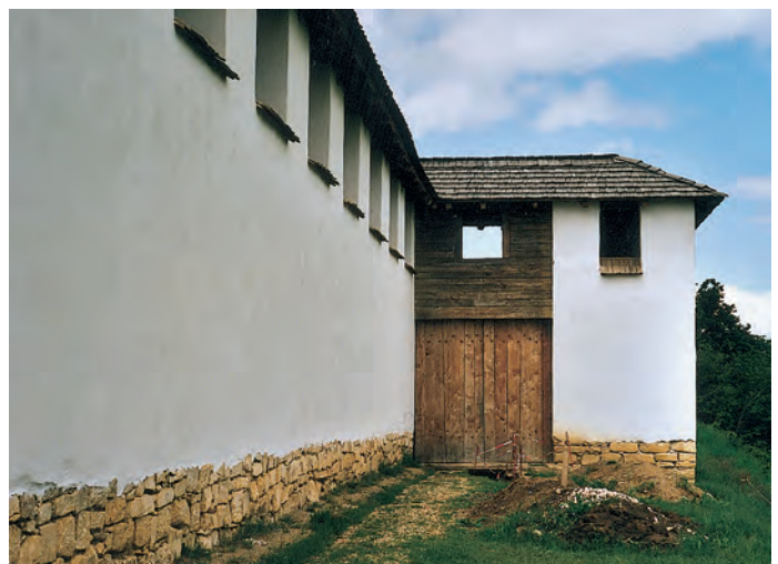
Rekonstruktion der berühmten Lehmziegelmauer auf der Heuneburg bei Herbertingen-Hundersingen. Die dicke Kalkschicht schützt die luftgetrockneten Lehmziegel dauerhaft.
