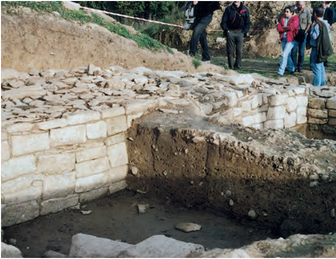
Die beiden Wangenmauern des keltischen Tores sind aus Material- und Arbeitersparnis als Zweischalen-Mauern gebaut worden. Rechts im Foto eine noch nicht abgegrabene Erdbrücke.
