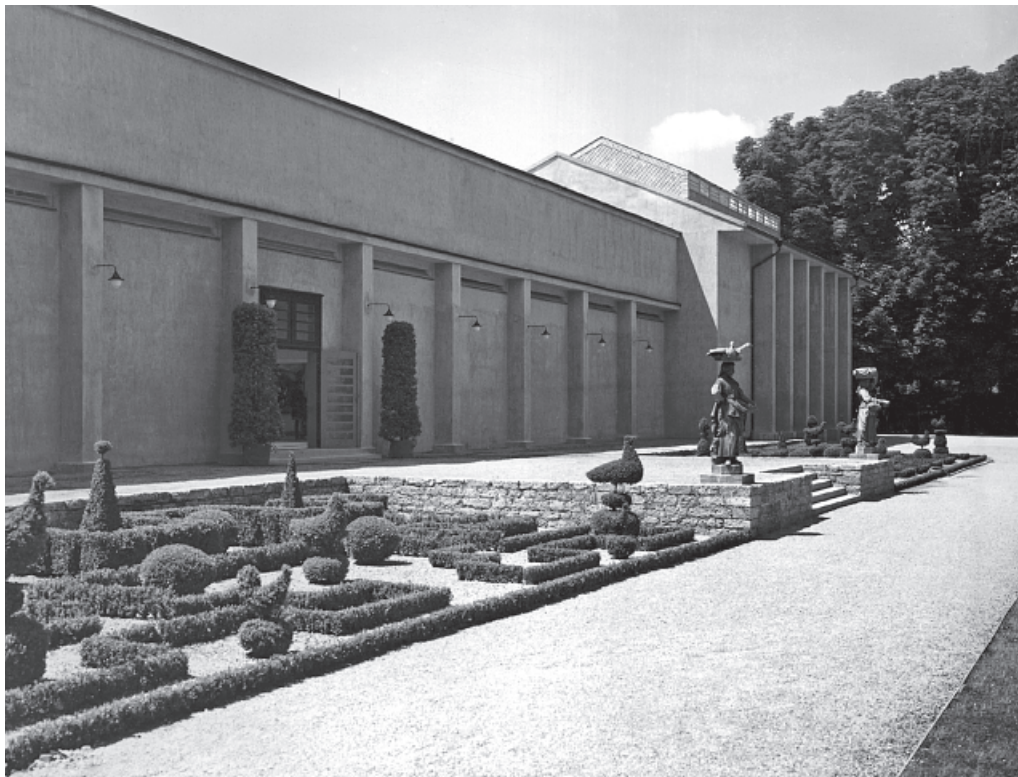
Das Provisorische Kunstausstellungsgebäude, 1924/25 in Holzfertigbauweise errichtet, war Pankoks letztes Projekt. Hier fanden die Ausstellungen der Stuttgarter Sezession statt.
