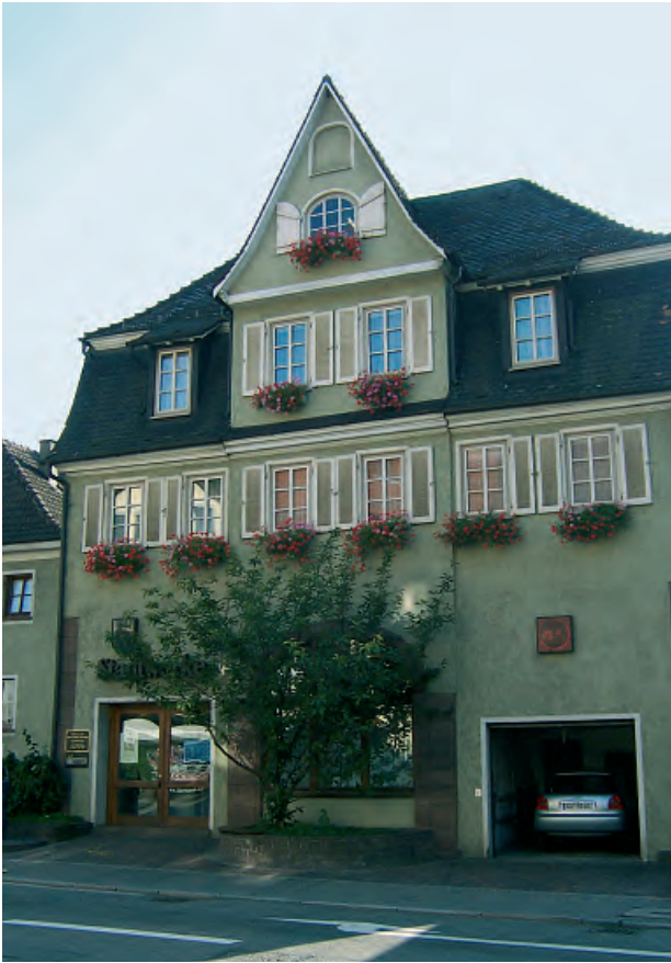
Das städtische Wasserkraftwerk in Calw baute Felix Schuster im Jahre 1911 im Stil eines alten Bürgerhauses, um sich dem Stadtbild anzugleichen. Die Funktion des Gebäudes ist von außen nicht zu erkennen.
