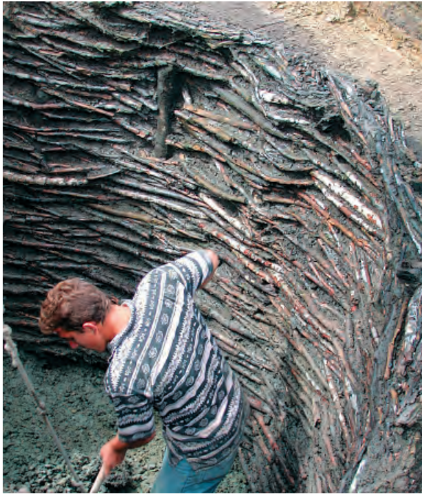
Dieser große öffentliche Brunnen auf dem später so genannten Holzmarkt war im elften Jahrhundert mit Lehm und Flechtwerk ausgekleidet.
