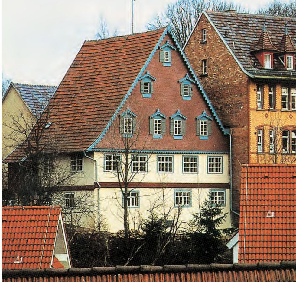
Die vorhandene Substanz wurde behutsam originalgetreu ergänzt. Um die neu eingebauten Teile als solche kenntlich zu machen, wurde maschinengehobeltes Holz mit sichtbaren Verschraubungen verwendet. Weitere Einzelheiten erübrigen sich hier, da bereits vor zwei Jahren Volker Lehmkuhl darüber in dieser Zeitschrift berichtet hat.
