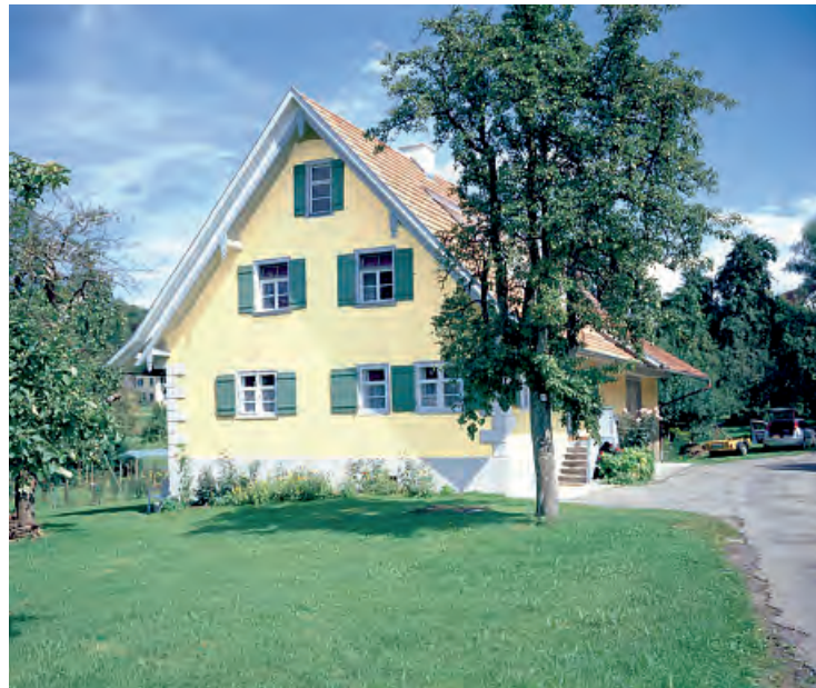
Die Giebelansicht zeigt wieder die historische Fenstergliederung mit Klappläden.
