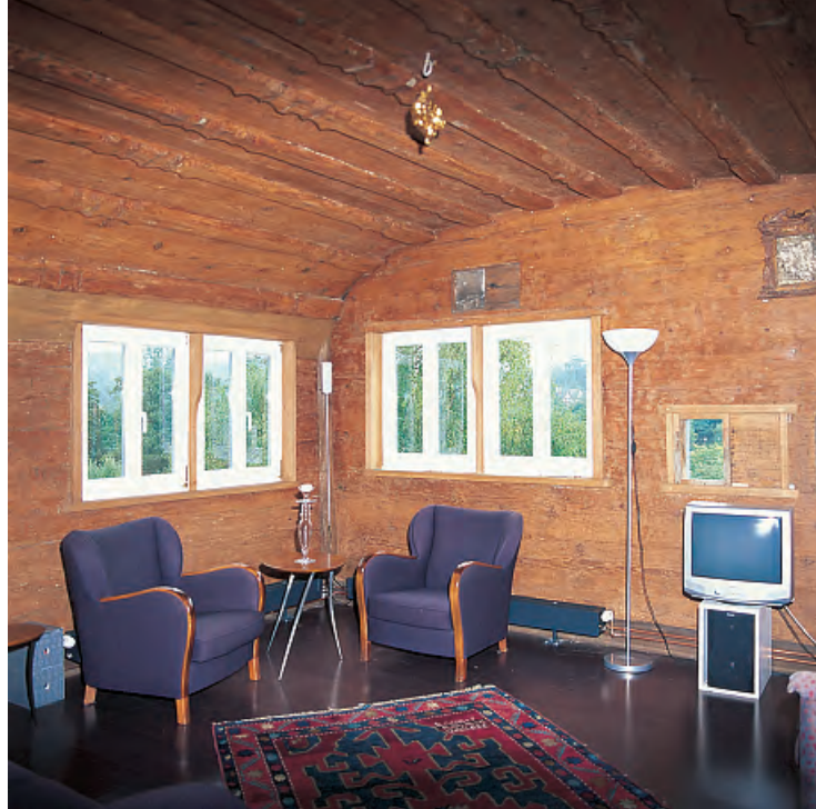
Die freigelegte und ergänzte Bohlenstube in ihrer originalen Holzschichtigkeit. Die Fenster sind Einbauten des 20. Jahrhunderts.
