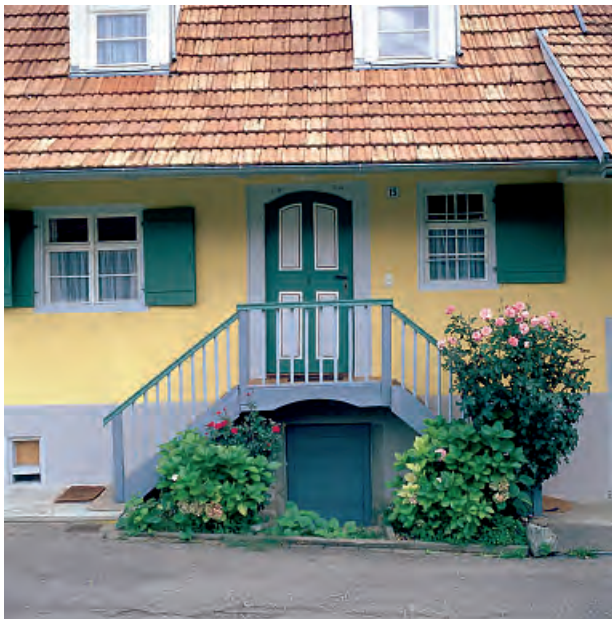
Zweiläufige Treppe über dem Kellerzugang. Der weite Dachüberstand schützt den Eingang.
