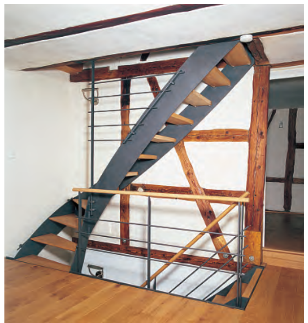
Unten: Eingestellte neue Treppe in leichter Stahlkonstruktion. Die platzsparende Konstruktion fügt sich in das historische Erscheinungsbild ein.
