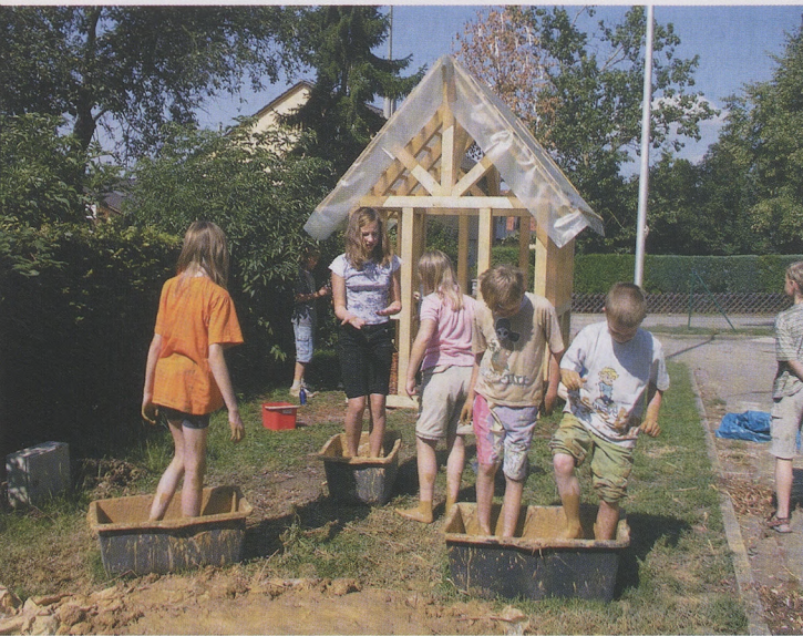
Ele(h)mentare Erfahrung für die Schulkinder: das Stampfen des Lehms für das Fachwerkhäuschen.
