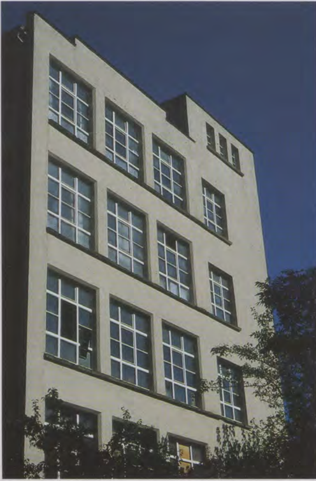
Im Bauhaus-Stil klar strukturiertes Firmengebäude von Ludwig Haasis in der Tailfinger Bahnhofstraße, 1931 vom Architekten Johann Miller.
