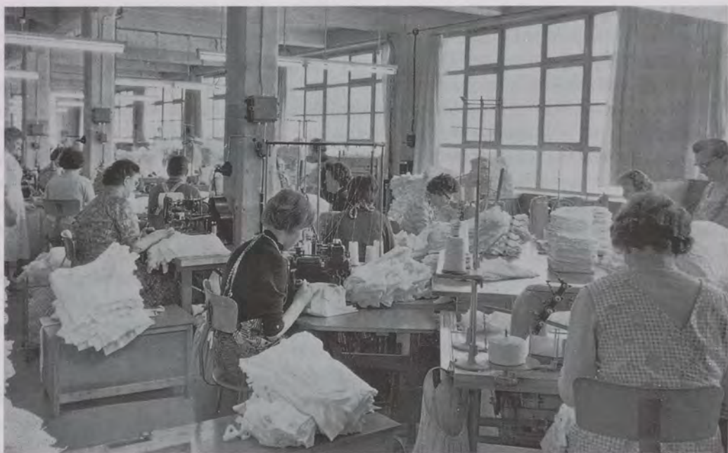
Durch die Bauhaus-Technik wurden auch die Produktionsstätten vom Licht durchflutet: hier ein Nähsaal der Tailfinger Firma J. Hakenmüller-Hasana.
