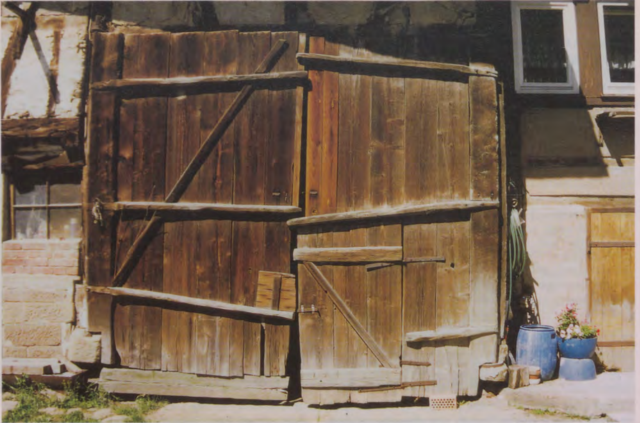
Noch funktionsfähiges Scheunentor mit Drehbalken und außen sichtbarer Tragekonstruktion aus dem Kraichgau.
