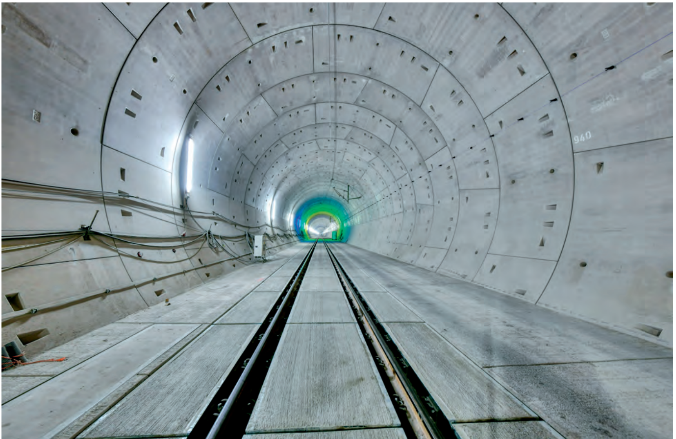
Blick in den Altvorlandtunnel Anfang Juli 2021, als die Gleisbauarbeiten weitgehend abgeschlossen waren. Dieser Tunnel mit einer Länge von 8.176 Metern unterfährt den Stadtteil Lindorf und die Anschlussstelle Kirchheim-Ost der BAB 8.
