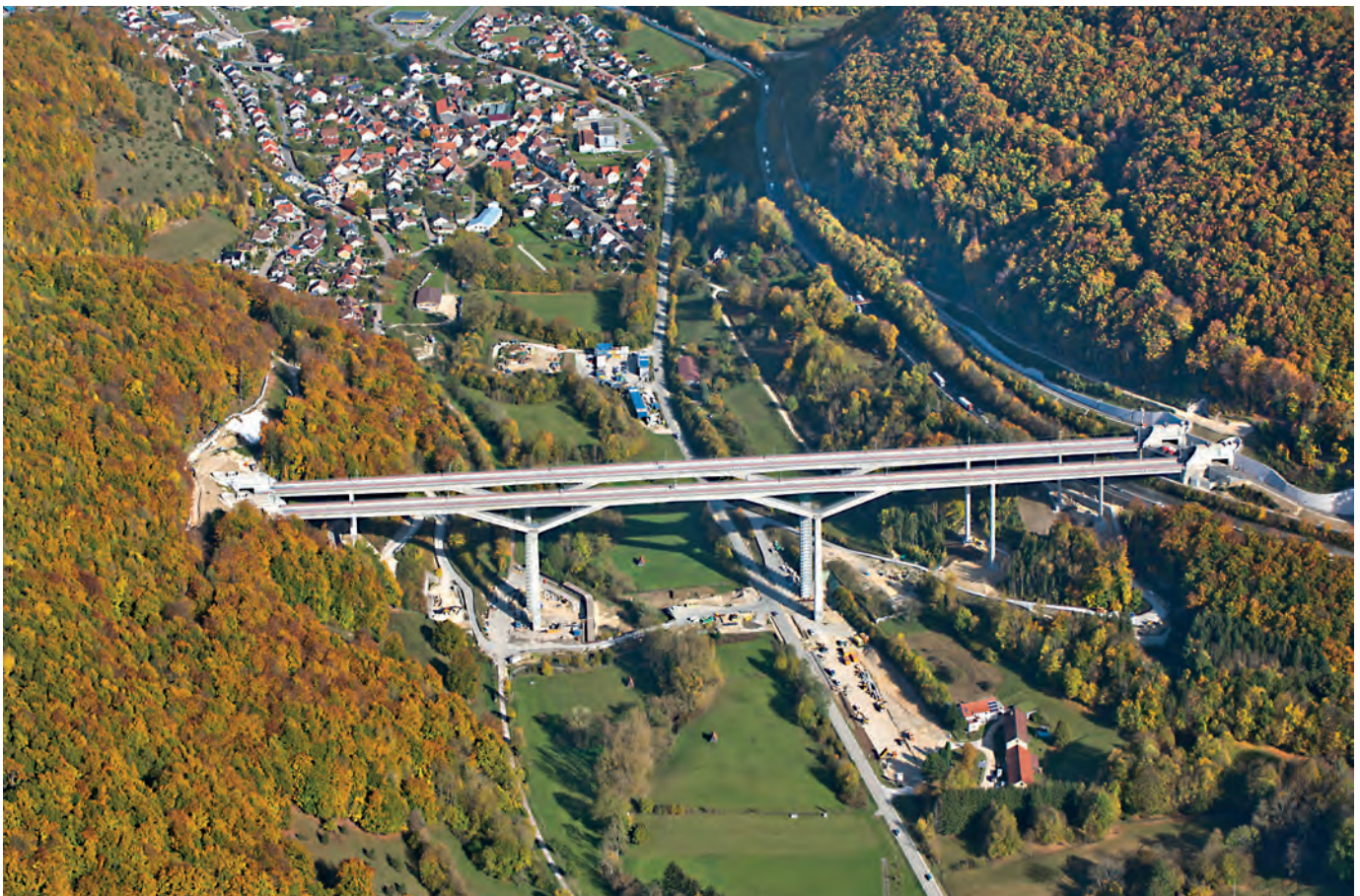
Die Brücke über das Filstal nach ihrer Fertigstellung im Oktober 2022
