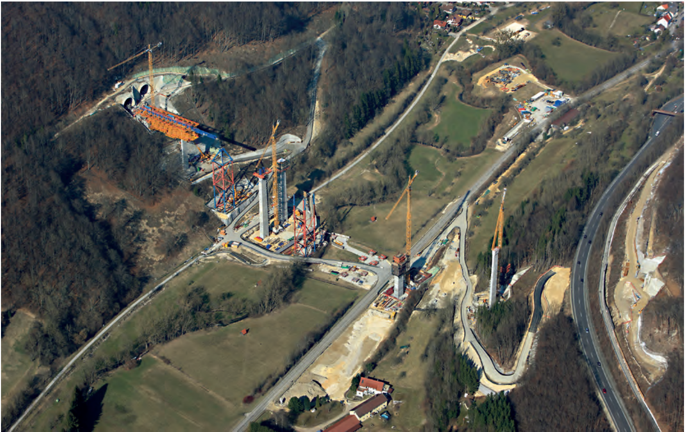
Bahntrasse Filstalbrücke im Bau, Aufnahme vom März 2018
