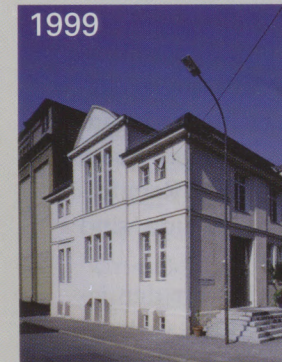
Ehem. Badhaus, Rottweil
