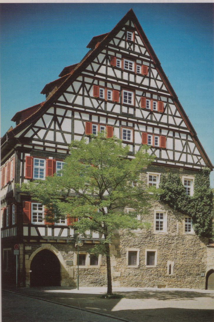
Der Königsbronner Pfleghof in Reutlingen. Deutlich sind der mittelalterliche Steinbau und die frühneuzeitlichen Fachwerkausbauten und -umbauten zu erkennen.
